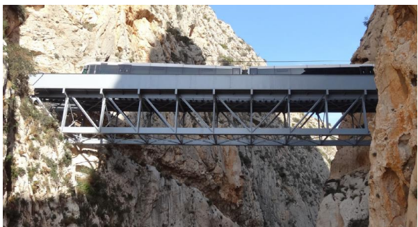
Figura 4. Puente sobre el barranco de Mascarat
