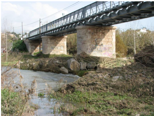
Figura 1. Viaducto sobre el río Algar
