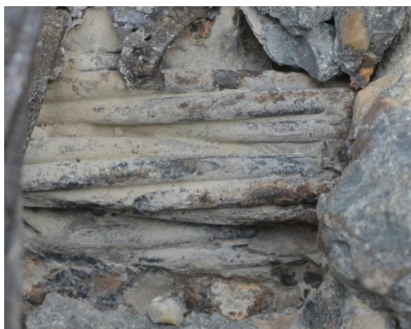
Figura 10. Calicata sobre pila 6. Foto de los autores, 12.02.2020.
