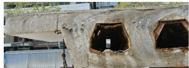
Figura 4. Sección de unas de las dovelas cortadas en las proximidades de un apoyo.
