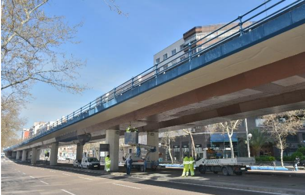
Figura 1. Escorzo del viaducto, 11 de marzo de 2020.
