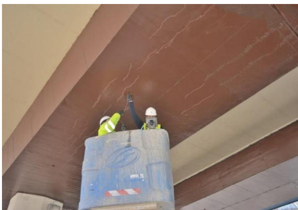
Figura 6. Fisuras longitudinales selladas en losa de fondo (foto de los autores, marzo de 2020).
