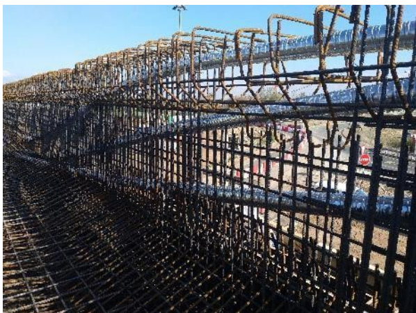
Figura 26. Disposición de pretesado en almas
