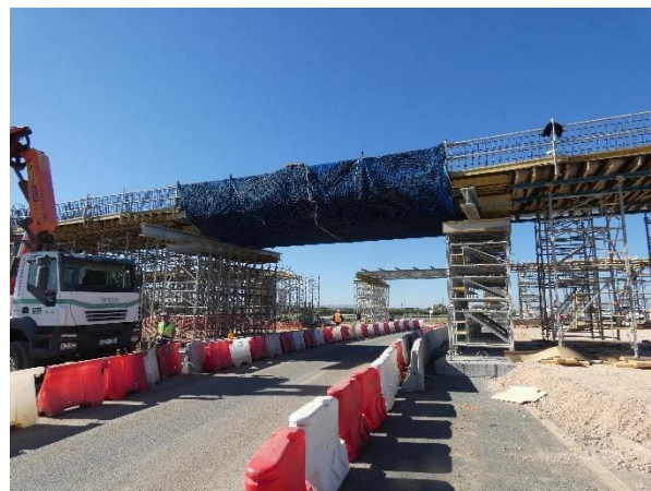
Figura 23. Vista de ejecución de cimbra porticada
