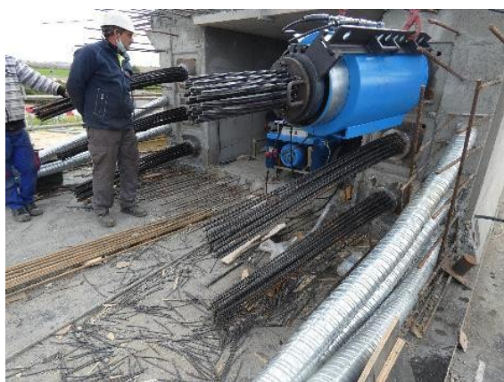
Figura 27. Imagen del proceso de tesado del pretensado
