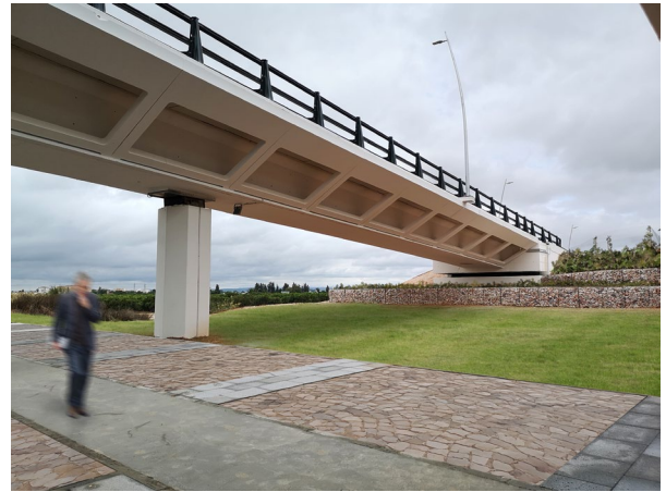
Figura 37. Vista del estribo del ramal de acceso
