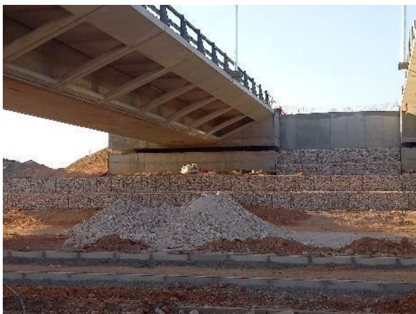
Figura 18. Muro dispuesto entre cargaderos pilotados
