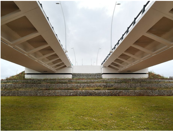
Figura 34. Vista de un estribo.
