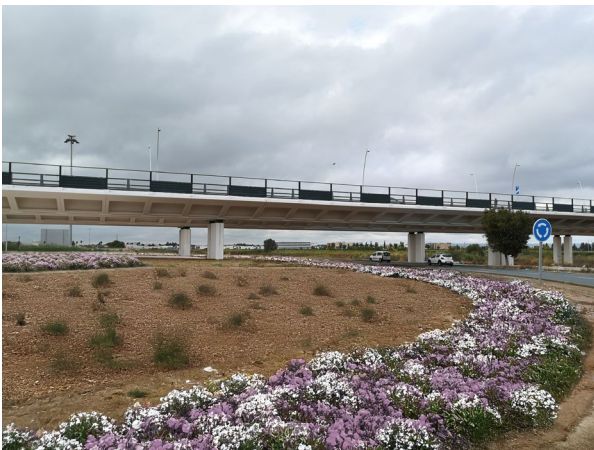
Figura 36. Paso del viaducto sobre glorieta existente
