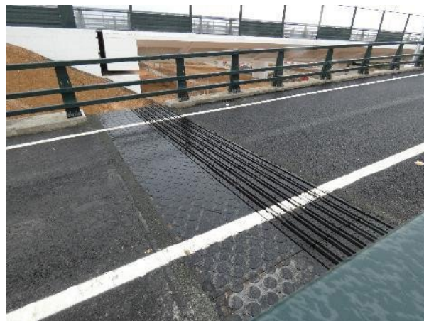
Figura 32. Juntas de dilatación dispuestas
