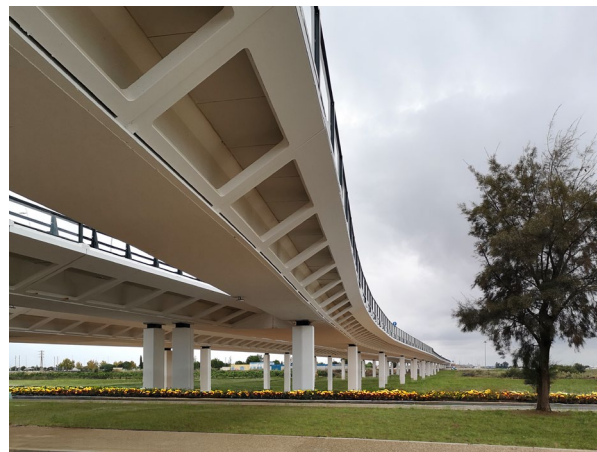
Figura 33. Vista del conjunto del viaducto terminado.
