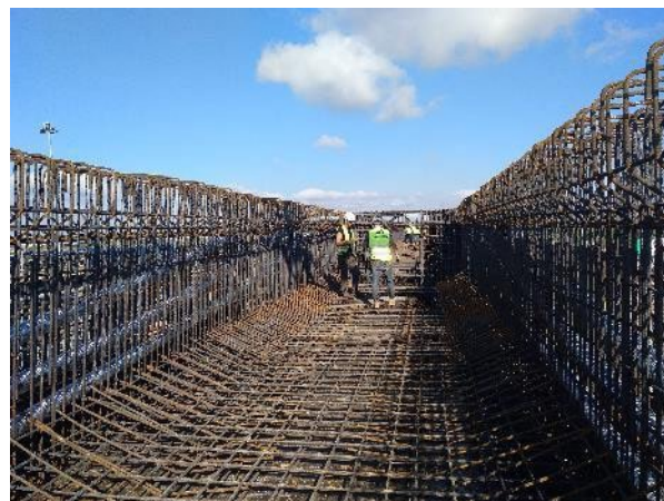
Figura 24. Ferrallado de la sección en “U”
