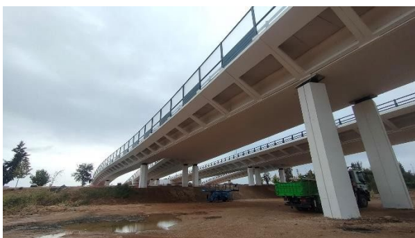
Figura 31. Jabalcones alabeados en vano de transición
