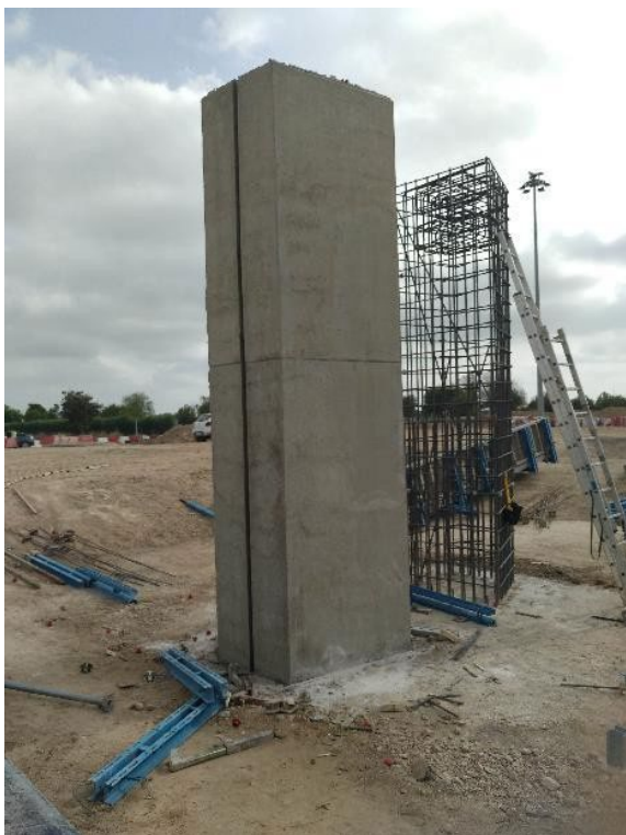
Figura 22. Vista de fuste ejecutado y ferralla del fuste paralelo
