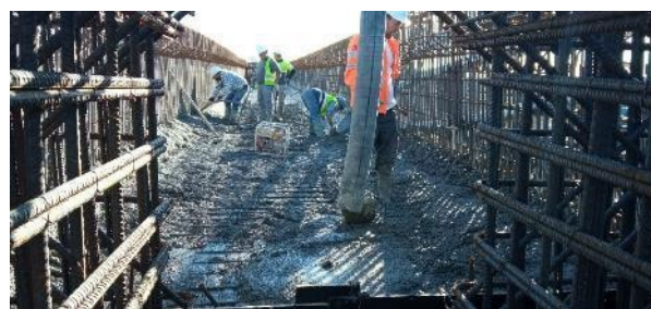
Figura 25. Hormigonado losa de fondo
