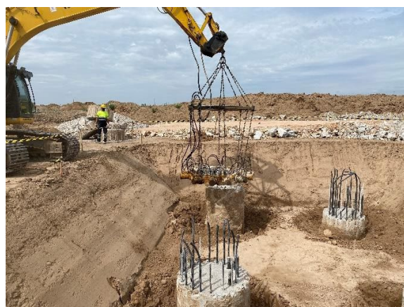
Figura 20. Descabezado de pilotes
