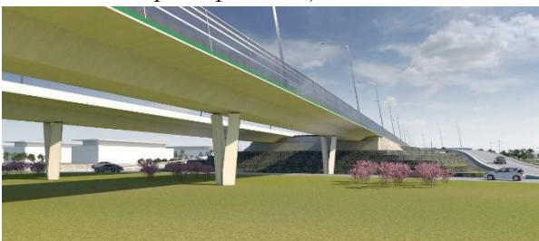
Figura 1. Solución tipo losa.
