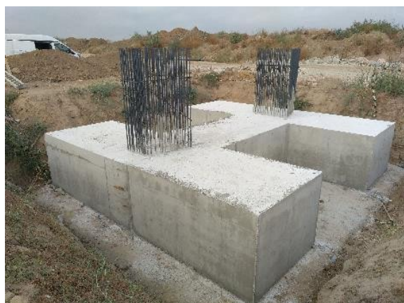
Figura 21. Vista de encepado ejecutado con armaduras en espera
