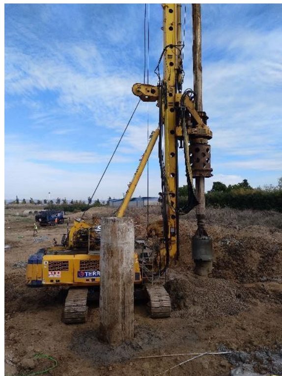
Figura 19. Ejecución de pilotes
