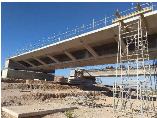
Figura 30. Proceso de colocación de jabalcones
