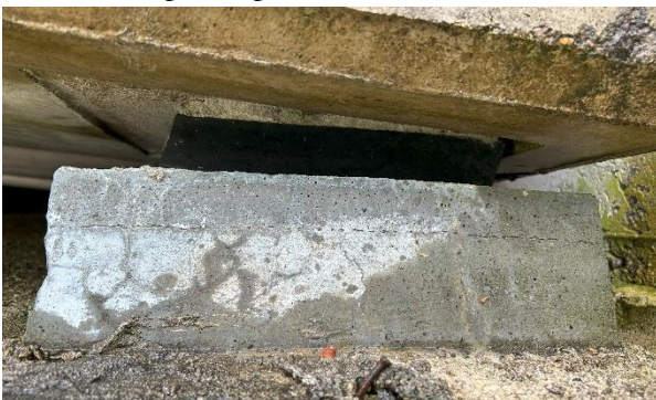
Figura 5. Condición actual de los aparatos de apoyo sin deterioro ni deformaciones significativas
