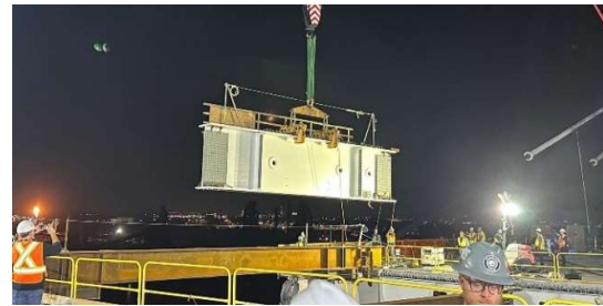
Figura 10: Montaje de una de las vigas longitudinales principales durante el cierre.
