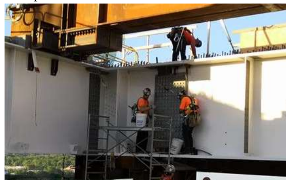
Figura 11: Atornillado de una de las vigas longitudinales durante el cierre.
