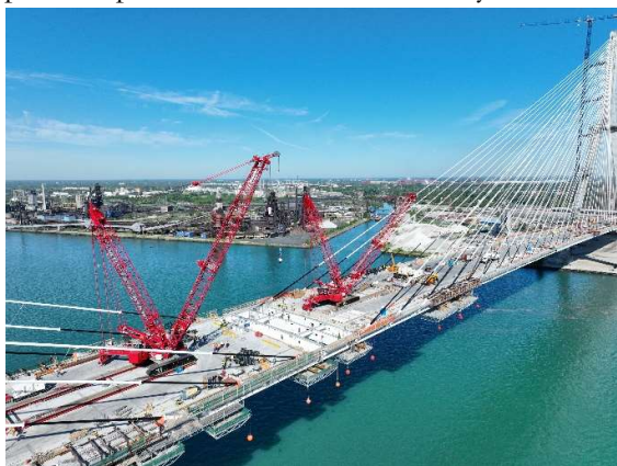
Figura 3. Vista general del tablero durante el montaje de elementos de la dovela de cierre.
