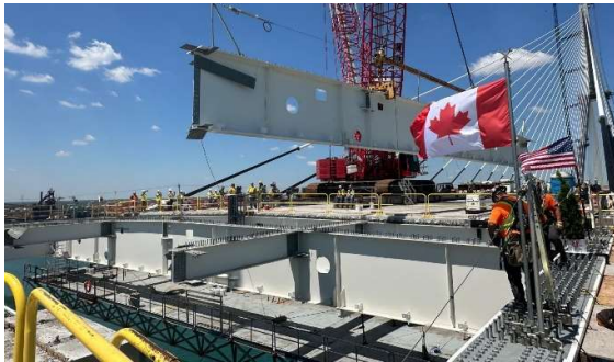
Figura 12: Montaje de una de las vigas transversales durante el cierre.
