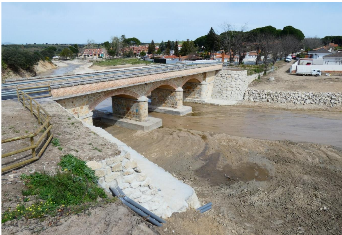
Figura 19. Vista aguas arriba del pontón después las obras de refuerzo y restauración
