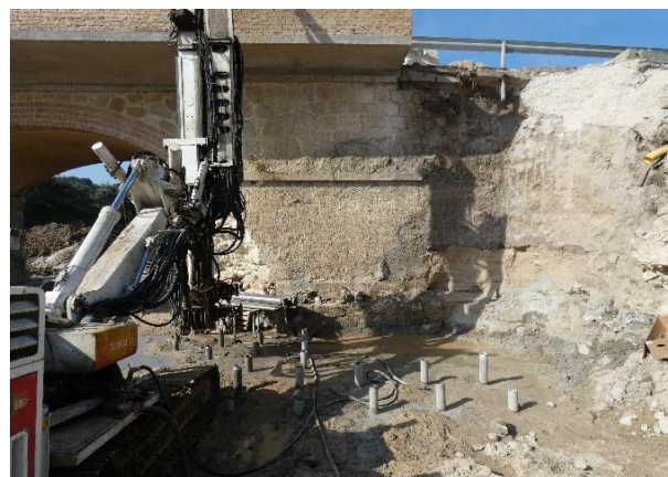
Figura 13. Ejecución de los micropilotes estribo 1, lado izquierdo
