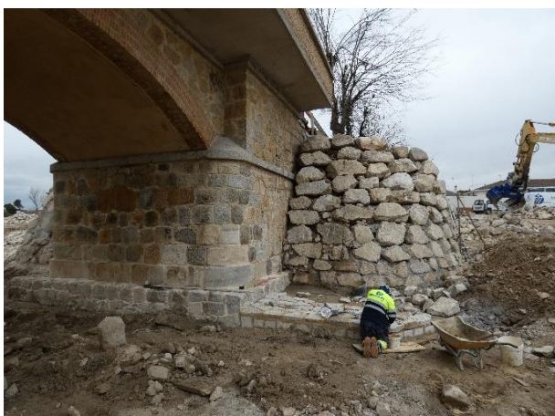
Figura 15. Reconstrucción de la fábrica original del estribo reutilizando las piezas originales rescatadas
