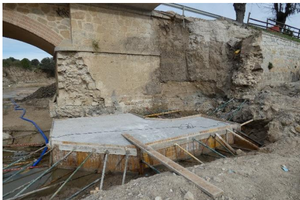
Figura 14. Ejecución del encepado de cimentación del estribo 1, lado izquierdo
