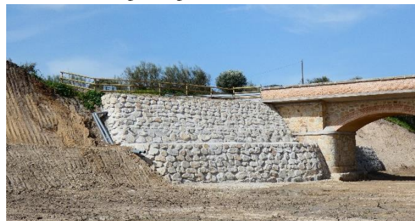
Figura 11. Muros de escollera en el estribo 2 (lado izquierdo)
