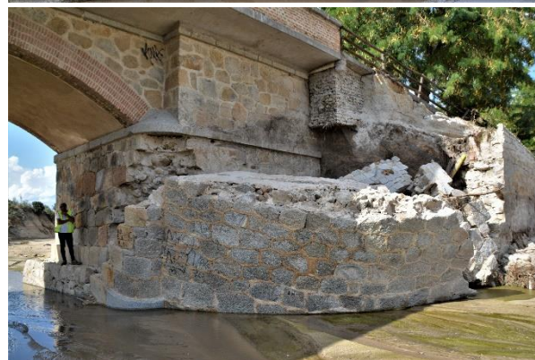
Figura 9. Descalce y vuelco de parte del muro frontal de estribo (arriba) y del muro de refuerzo de 1966
