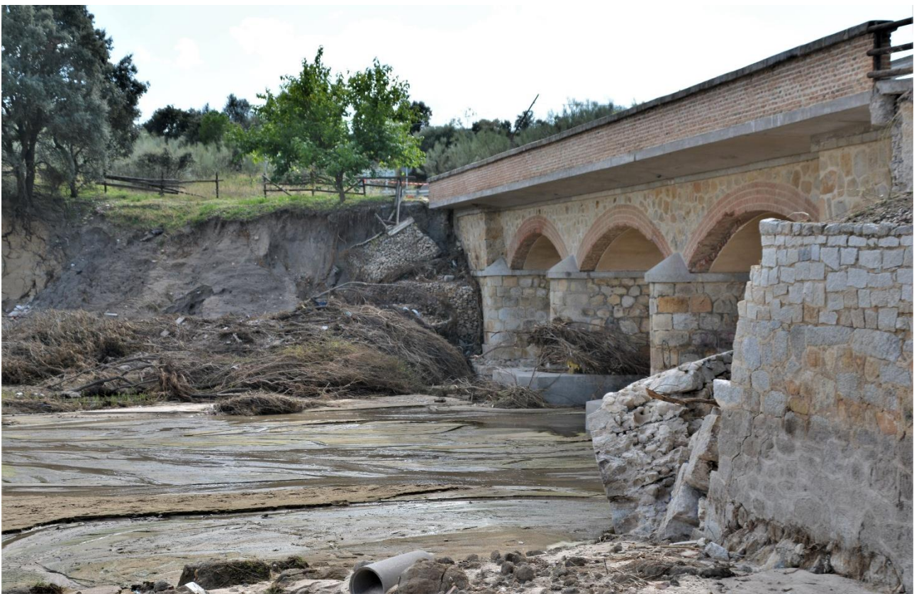
Figura 6. Escorzo desde estribo norte, aguas arriba del pontón después los efectos catastróficos de la dana
