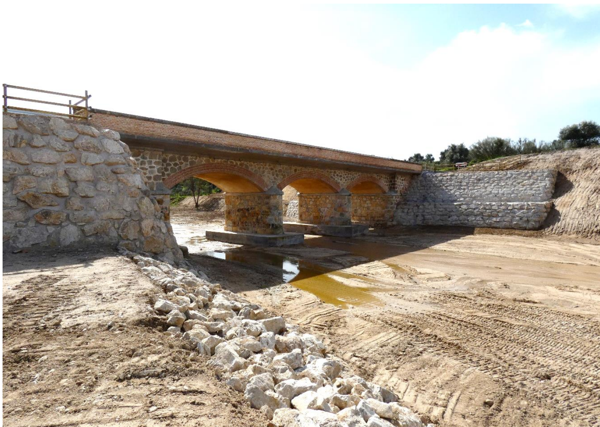
Figura 20. Vista aguas abajo del pontón después las obras de refuerzo y restauración
