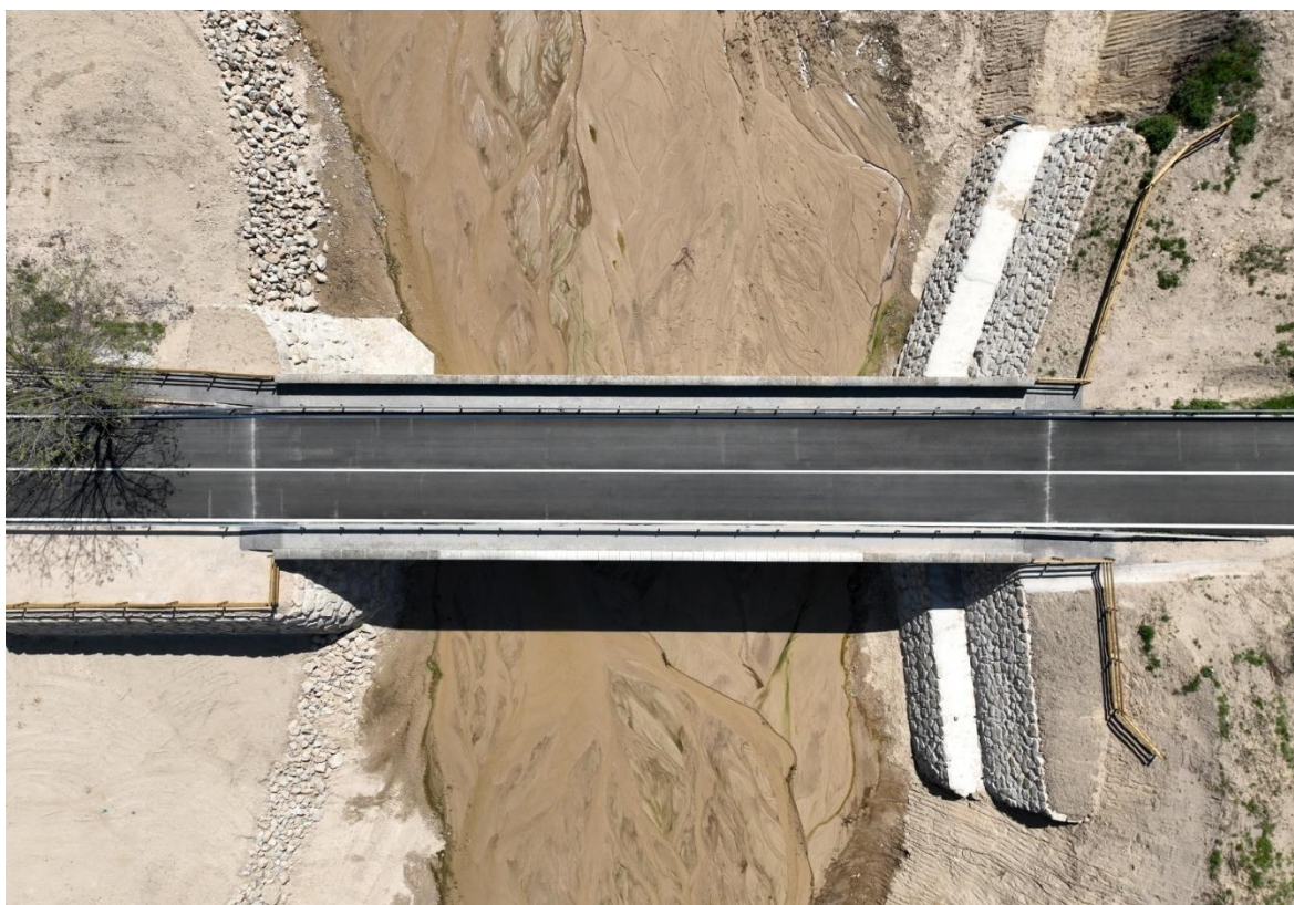
Figura 21. Vista área del pontón después las obras de refuerzo y restauración
