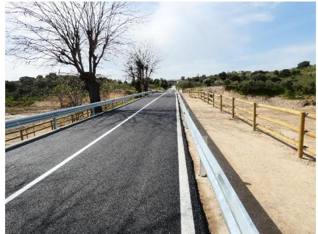
Figura 18. Vista calzada estribo 1, lado derecho
