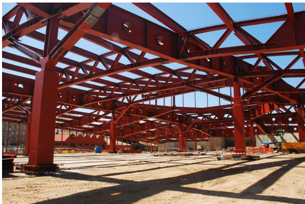
Figura 4. Estructura metálica de la estación
