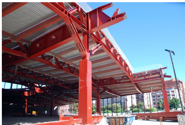
Figura 9. Cubierta, forjado mixto y pilares
