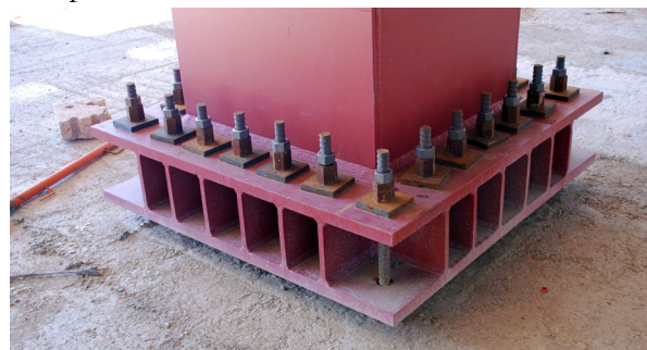
Figura 10. Placa base de los pilares centrales
