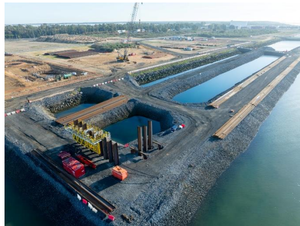
Figura 11. Fotografía tomada en la zona de proyecto. Hinca de perfiles metálicos.
