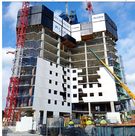
Figura 17. Montaje de fachada
