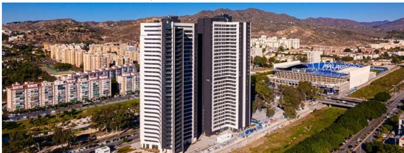
Figura 18. Vista general del complejo
