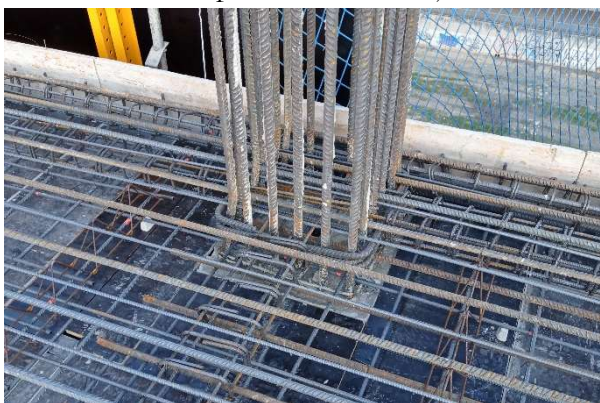
Figura 2. Cercos de confinamiento en soportes
