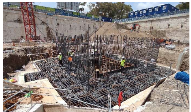
Figura 9. Encepado de núcleo torre T
