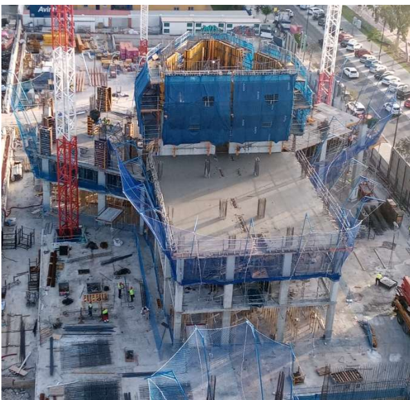
Figura 6. Torre Y durante su construcción
