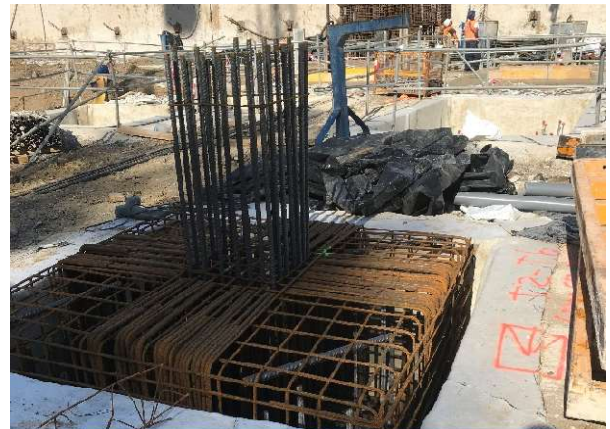
Figura 8. Encepado de pilares de torres
