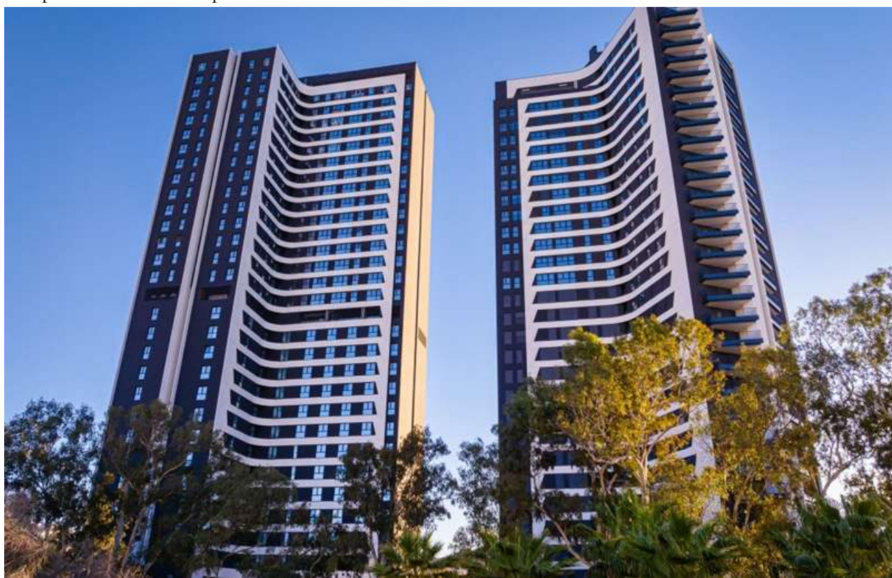
Figura 1. Vista general del complejo
