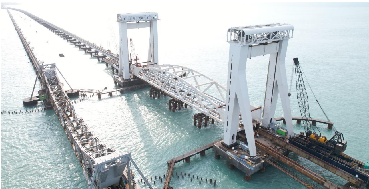
Figura 22. Fase final lanzamiento tramo de elevación (cimentaciones provisionales vano principal)
