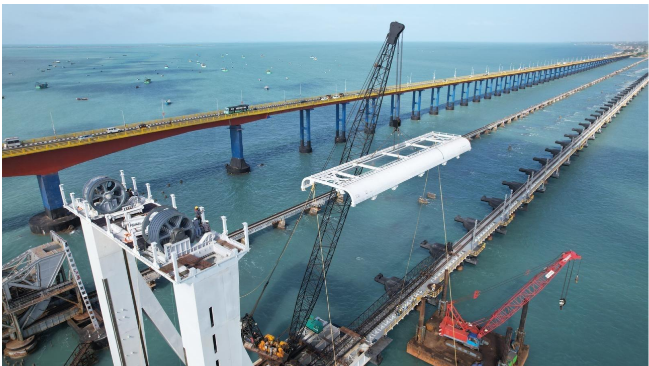
Figura 23. Izado del segmento superior del dintel para su instalación mediante uniones atornilladas
