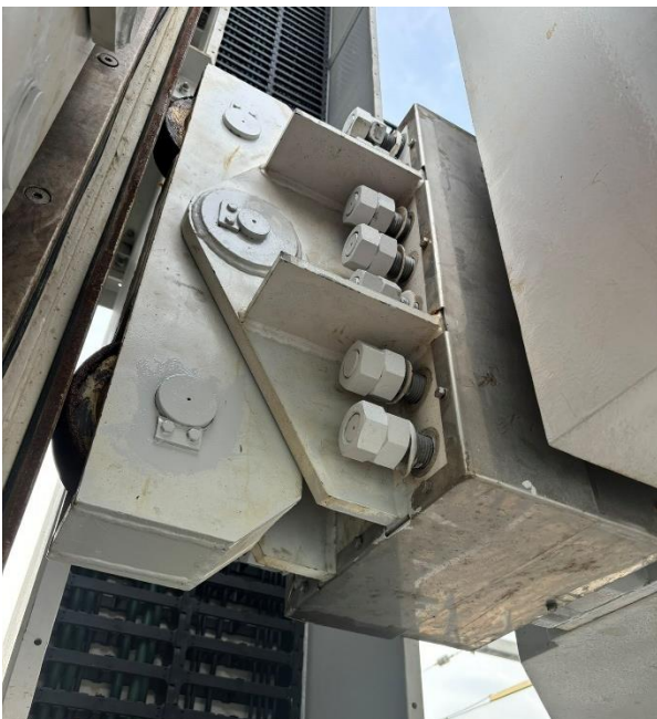
Figura 12. Guía transversal tablero
