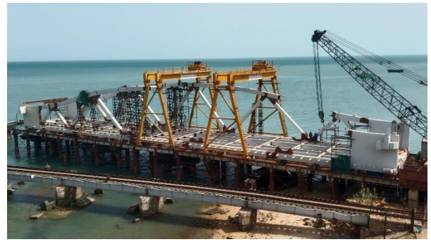
Figura 20. Ensamblaje módulos
