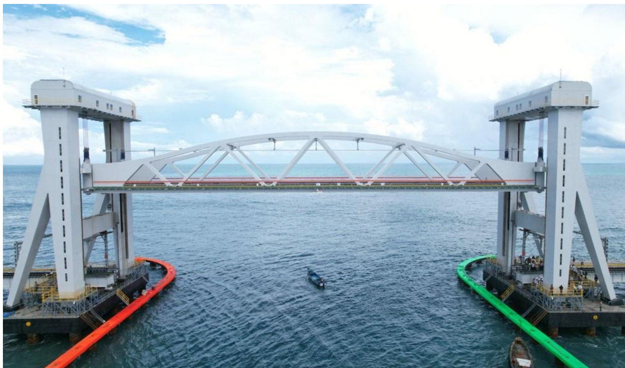
Figura 2. Nuevo puente móvil Pamban Bridge, en posición abierta
