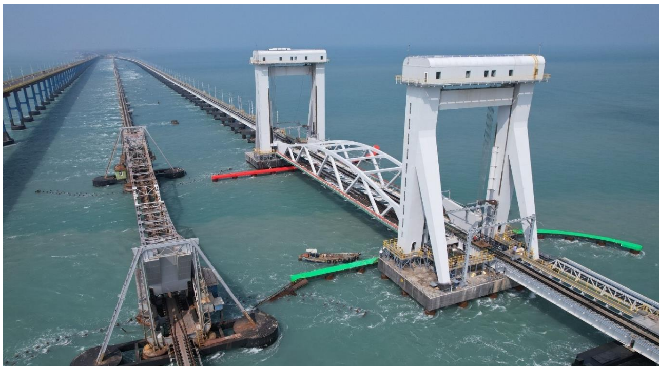
Figura 1. Nuevo puente móvil Pamban Bridge, en posición cerrada junto con el antiguo puente, de tipología “Scherzer Rolling Bascule”, al que sustituye.
