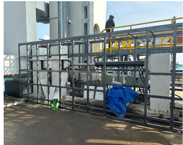
Figura 10. Enclavamiento del tablero
