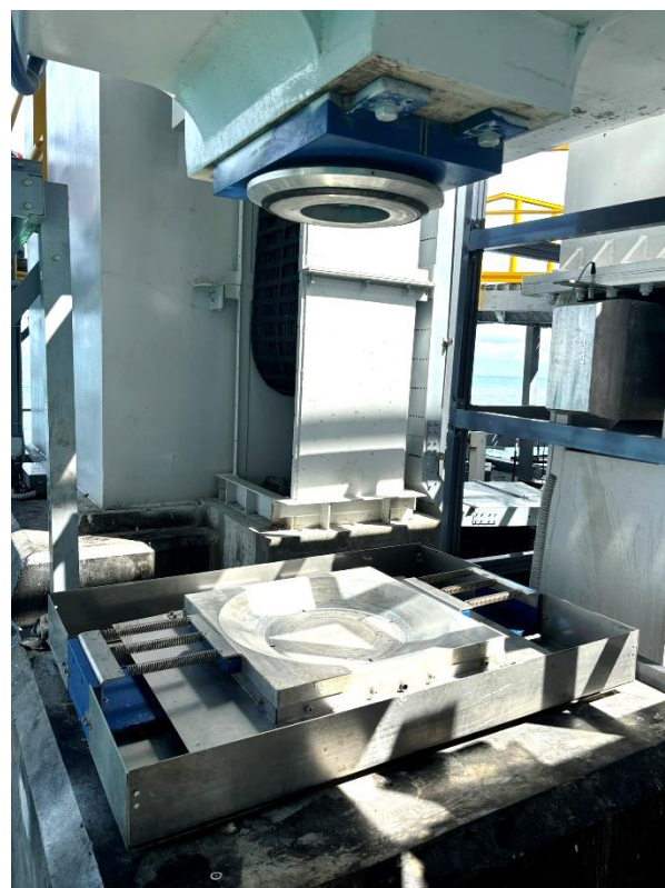
Figura 5. Apoyo durante levantamiento
