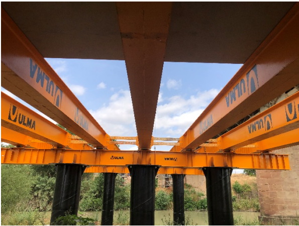
Figura 11. Estructura del puente provisional.
