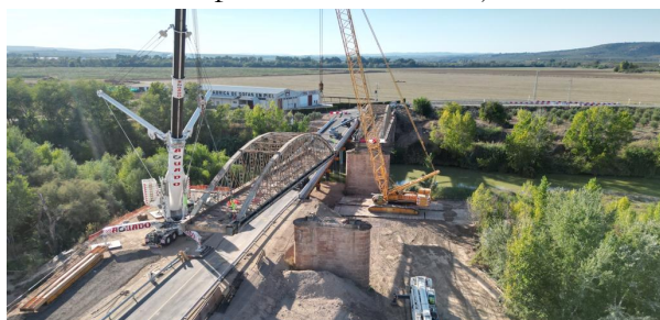
Figura 15. Transporte de tramo metálico a plataforma de trabajos.
