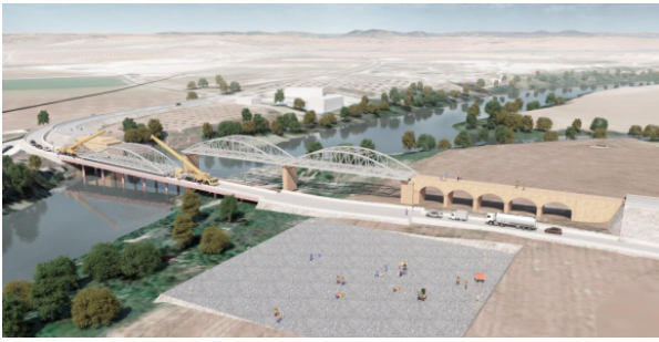
Figura 18. Colocación de tableros metálicos en su posición final.
