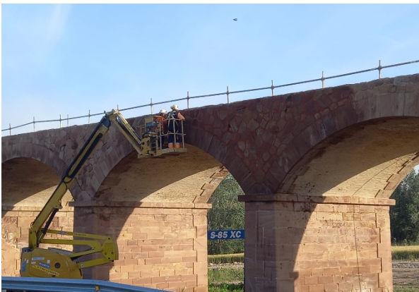
Figura 9. Trabajos de rejuntado en sillería.
