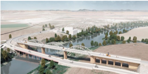
Figura 19. Finalización de nuevos tableros.
