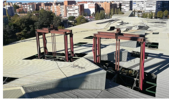
Figura 17. Vista exterior de las torres. En rojo los ductos para el hormigonado de cimentación.
