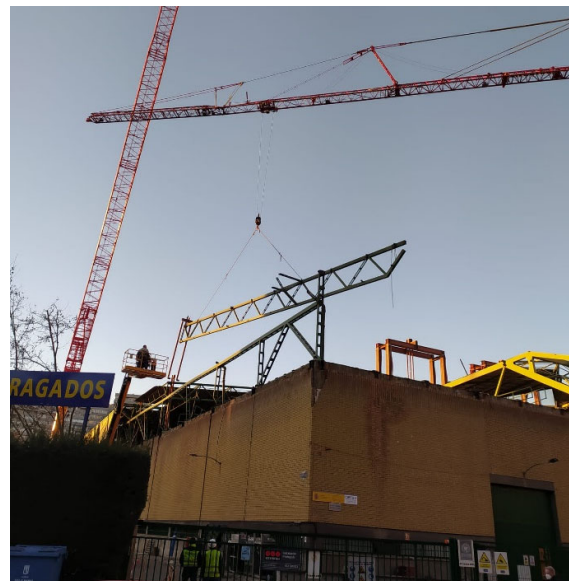
Figura 21. Retirada de celosías secundarias.
