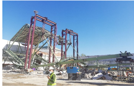
Figura 28. Zona despejada celosías principales.
