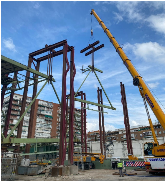
Figura 27. Desmontaje celosías principales.
