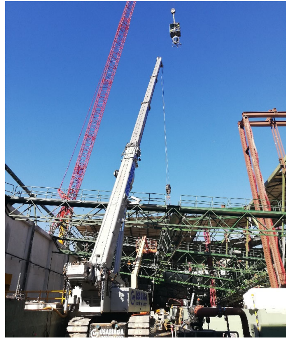
Figura 24. Retirada de pasarelas desde el interior.
