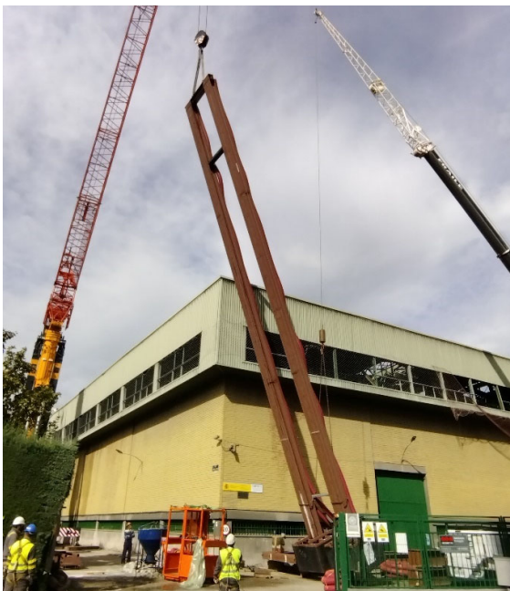
Figura 16. Trabajos de verticalización de apeos celosías principales.
