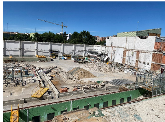
Figura 29. Zona Nave despejada.
