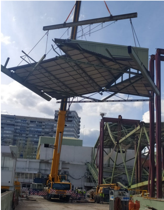
Figura 26. Desmontaje del lucernario entre celosías principales.
