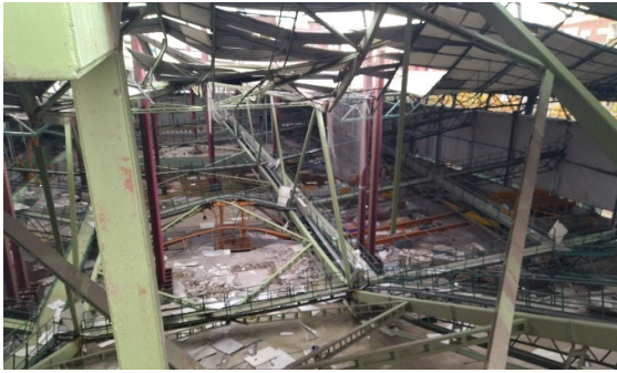
Figura 15. Vistas interior de la nave con los apeos de cerchas principales.
