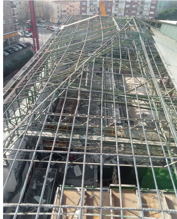
Figura 20. Retirada de cubierta, zona sureste.
