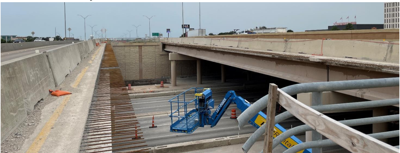
Figura 5. Esperas de armaduras transversales en Central Drive tras hidrodemolición.
