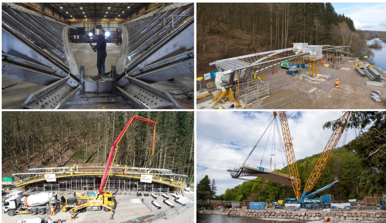
Figuras 11 a 14. De arriba abajo y de izquierda a derecha: Fabricación de la estructura metálica en taller; Ensamblaje en obra; Hormigonado del arco; Instalación del vano principal con grúa.
