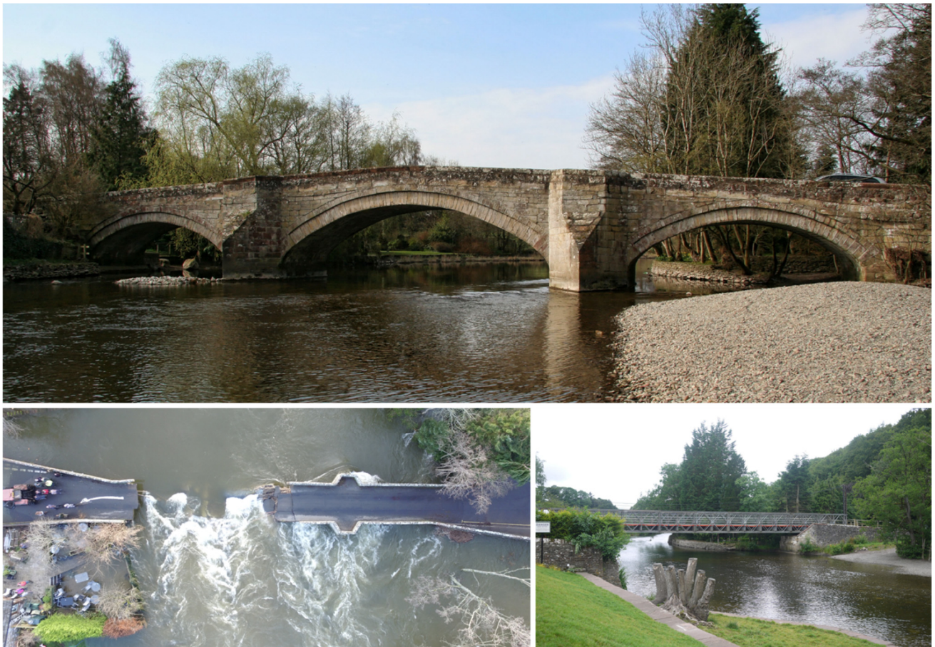
Figuras 1 a 3. De arriba abajo y de izquierda a derecha: Puente histórico de Pooley; Puente histórico arrastrado por las riadas causadas por el Ciclón Desmond; Puente temporal instalado en 2016.
