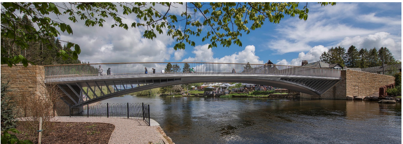
Figura 15. Vista del puente desde aguas arriba.
