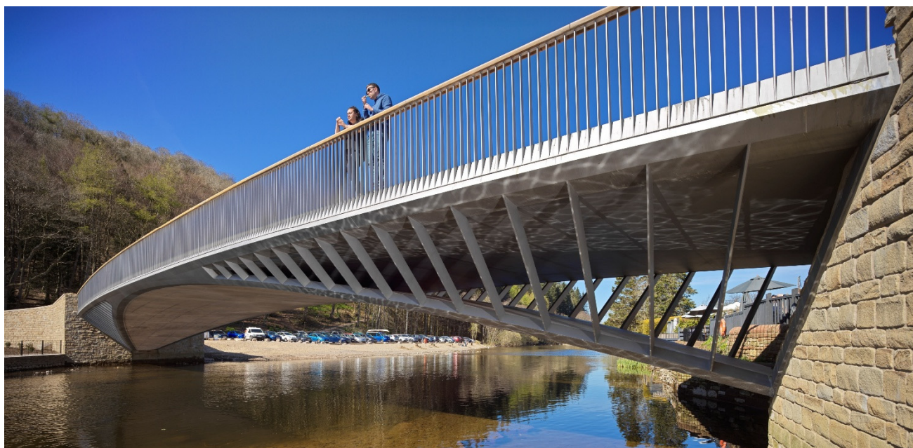
Figura 9. Vista en escorzo del puente desde aguas arriba.
