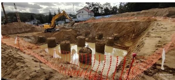
Figura 5. Recinto de excavación. Estribo 2
