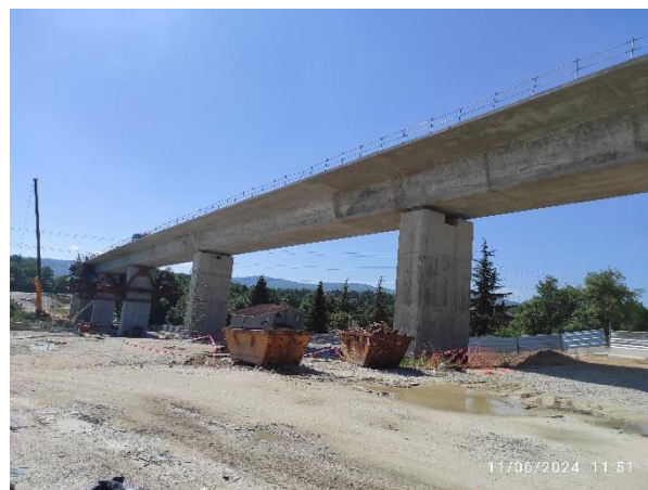
Figura 7. Vista de las pilas una vez construidas.
