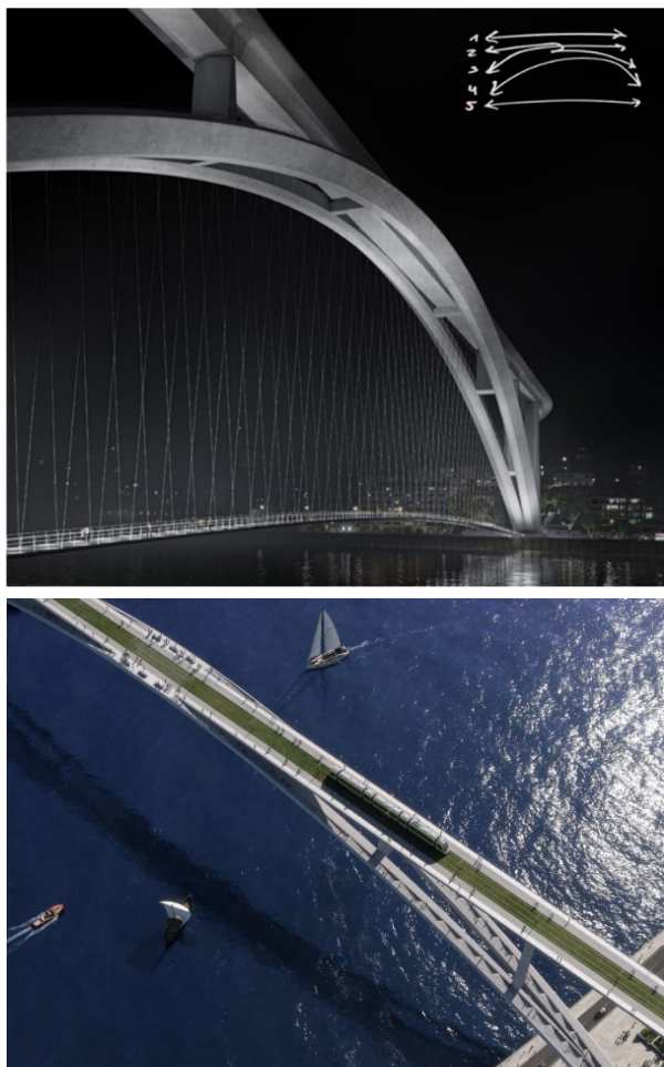
Figuras 7a y 7b. Puente de metro de Oporto.
