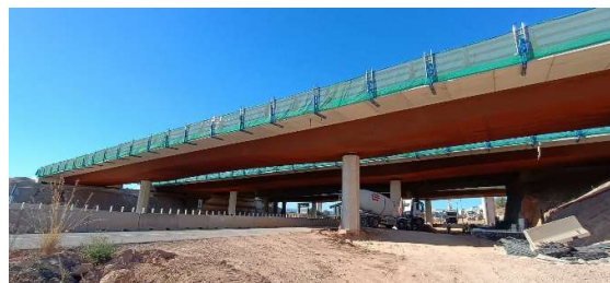
Figura 4. Vista de estructuras enlace V-30 ya montadas.
