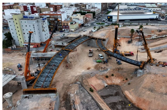
Figura 2. Vista del montaje de estructura E-1 (izado de tramo de cierre con 2 grúas).
