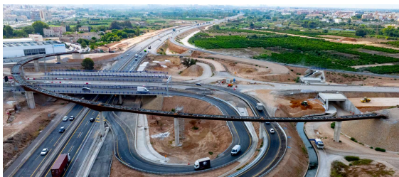
Figura 10. Vista aérea de estructura metálica E13 montada.
