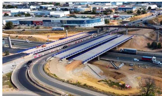
Figura 7. Estructuras E10, E11 y E12 hormigonadas.
