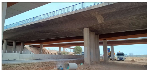
Figura 3. Vista de la estructura de cruce existente sobre V-30.
