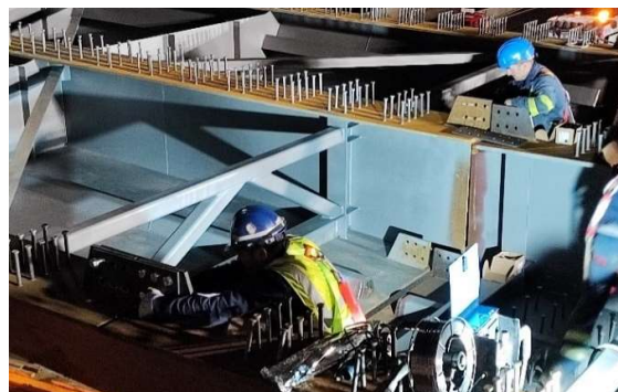
Figura 19. Atornillado de los útiles de tangencia.
