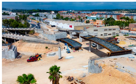
Figura 1. Vista de montaje de estructura E-2 (tramo de cierre apeado).
