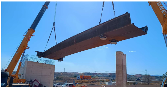
Figura 21. Izado de tramo metálico con apoyos atornillados a las cuñas.
