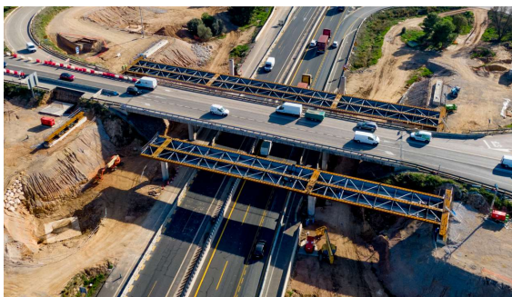
Figura 5. Vista de situación de montaje intermedia. E10 montada, E12 montados los 2 primeros tramos.
