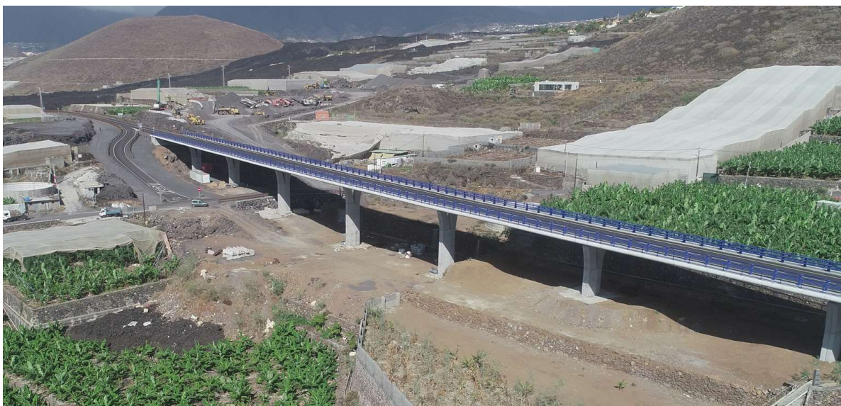
Figura 24. Vista aérea lateral del viaducto terminado.
