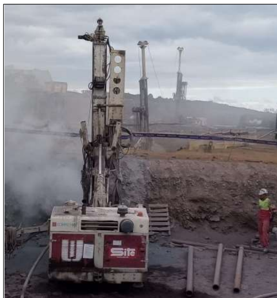
Figura 6. Máquina de micropilotes trabajando
