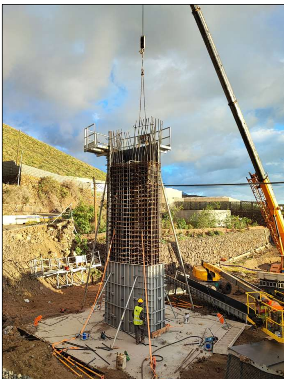
Figura 8. Ejecución de pilas. Ferralla y encofrado para primera fase (monofuste).
