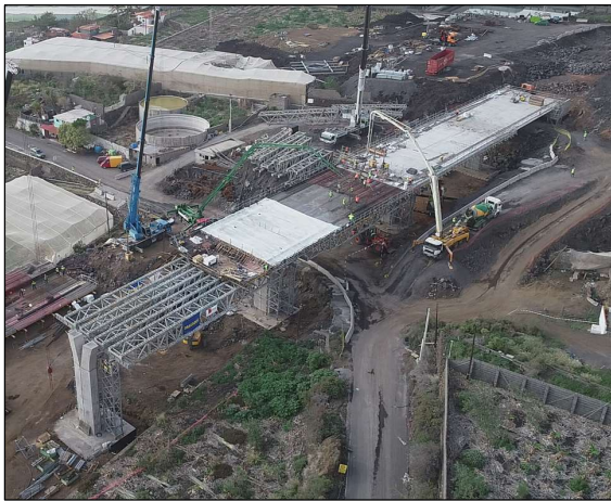
Figura 17. Vista aérea. Fase 3 de hormigonado.
