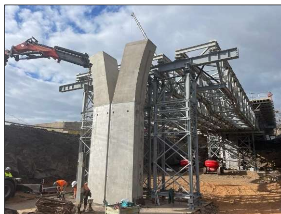
Figura 11. Vista de alzado de pila 1 terminado.
