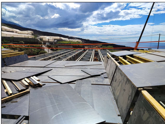
Figura 19. Instalación de paneles de encofrado sobre los barcos de la cimbra.
