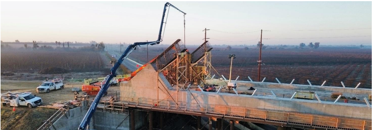
Figura 17. Vista del arranque del arco e inicio del montaje de la cimbra del arco.
