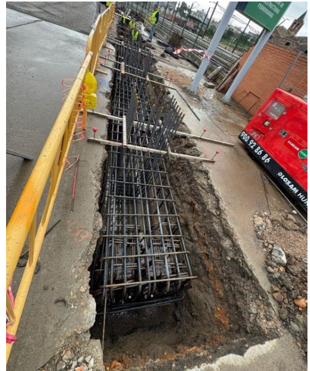
Figura 32. Cimentación de la empalizada
