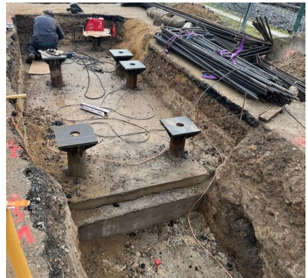
Figura 33. Cimentación de la Pila 9
