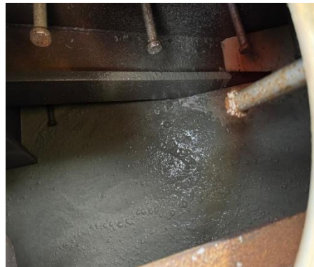
Figura 26. Hormigón en el interior del arco
