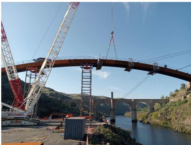
Figura 20. Izado de dovela 8 tramo atirantado
