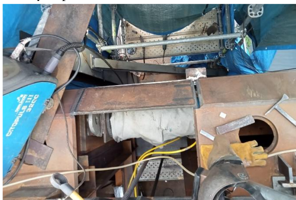
Figura 25. Soldadura de la clave
