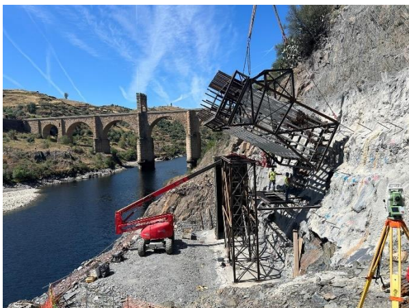
Figura 5. Estructura auxiliar para la colocación de barras de anclaje en semiarco derecho
