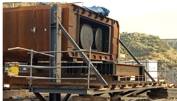
Figura 21. Estructura auxiliar inferior
