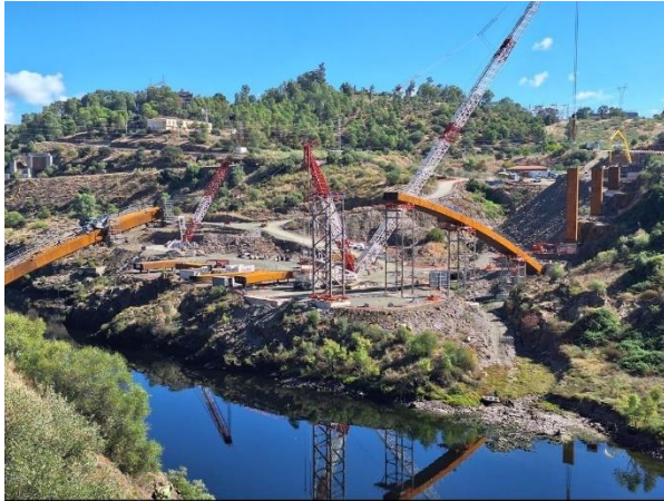
Figura 9. Torres de apeo en semiarco izquierdo
