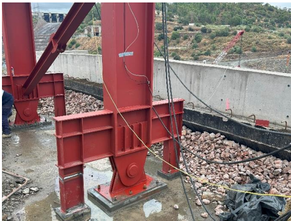
Figura 12. Unión bulonada con estabilizadores
