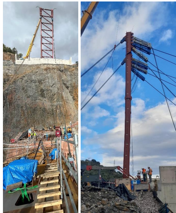
Figura 10. Torre de atirantamiento
