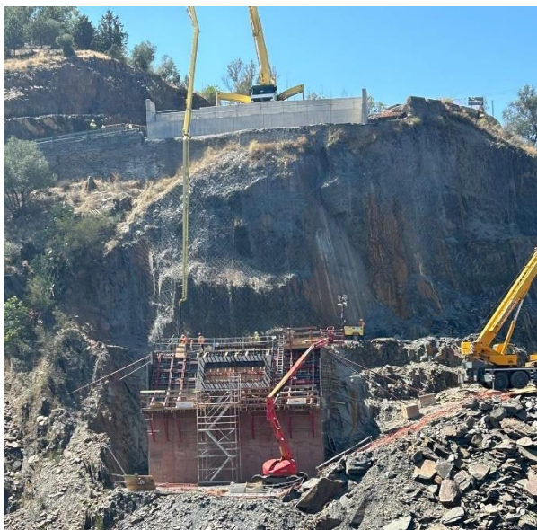
Figura 6. Hormigonado de la segunda fase del semiarco derecho
