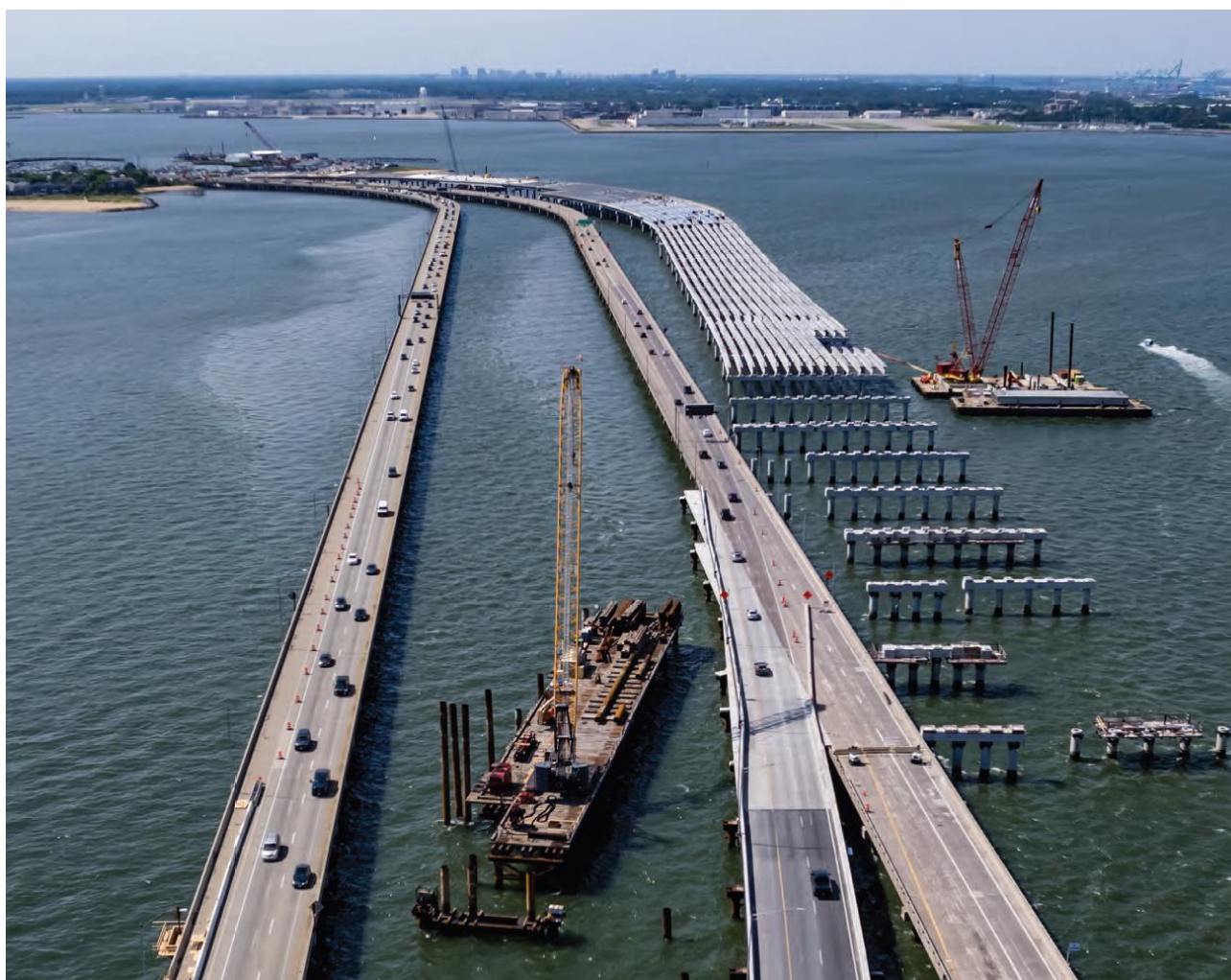
Figura 3. Montaje de vigas en el viaducto Sur.
