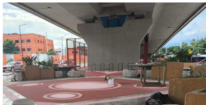
Figura 3. Pila del viaducto
