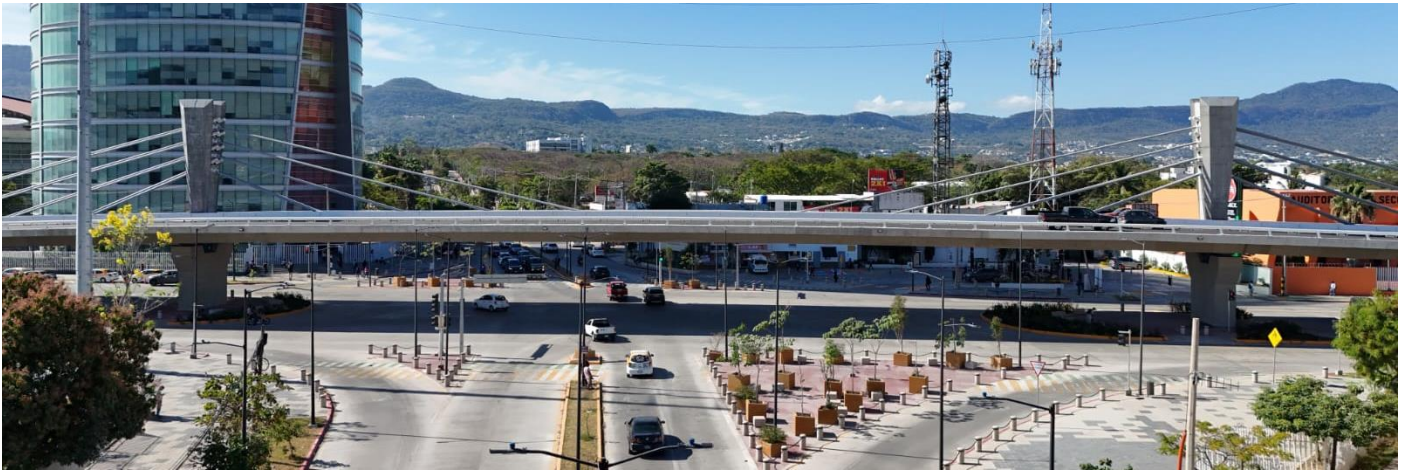
Figura 9. Zona central del viaducto terminado
