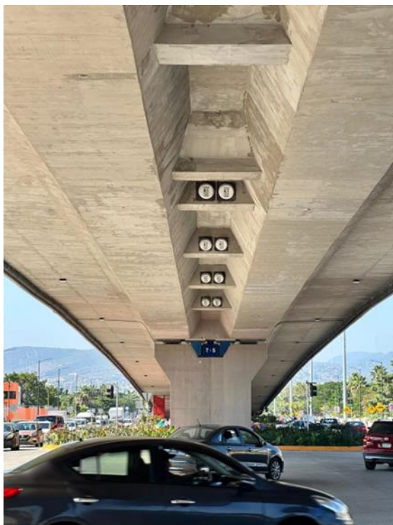
Figura 6. Vista inferior del tablero
