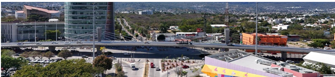
Figura 1. Vista general del viaducto
