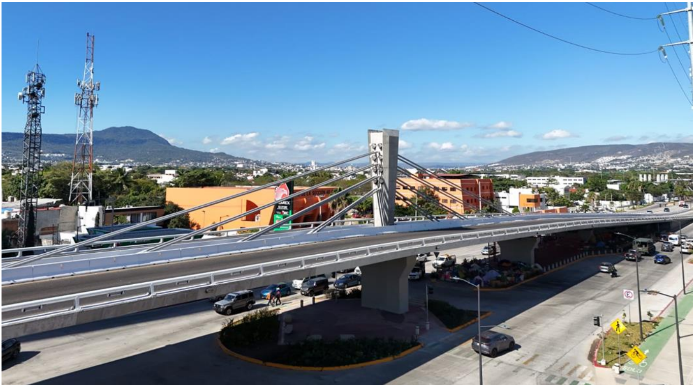
Figura 4. Torre y vista general del viaducto
