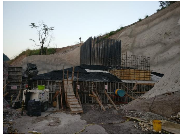
Figura 2. Colado zapata P2.
