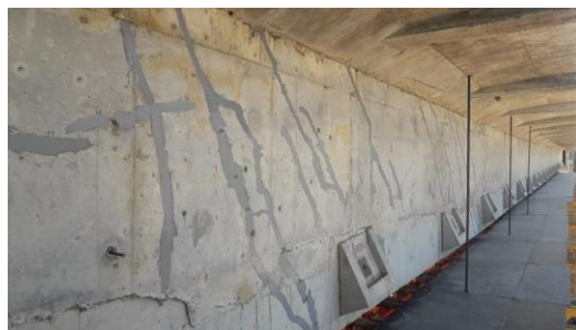
Figura 8. Inyección de fisuras.
