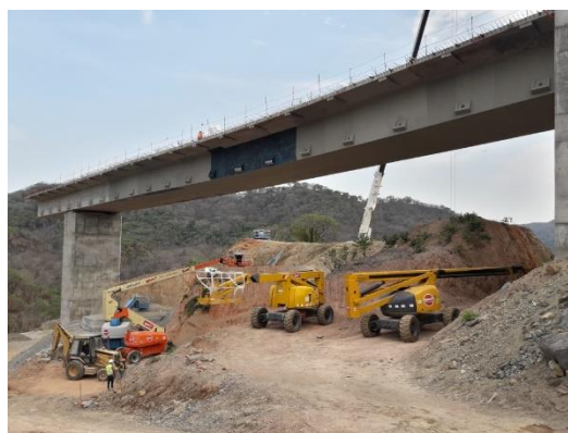
Figura 9. Refuerzo fibra de carbono.
