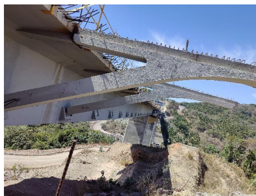
Figura 14. Montaje jabalcones.
