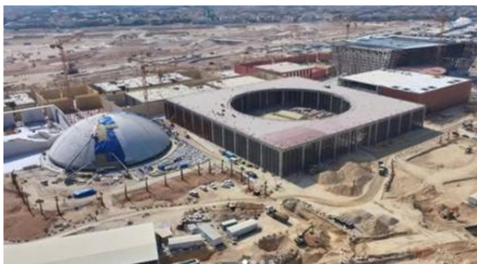
Figura 26. Vista aérea de la obra, a la izquierda el Dome y a la derecha el National Theatre.
