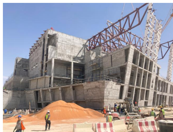
Figura 11. Vista de la fachada inclinada y de las pantallas perimetrales de hormigón (Sep. 2024) (Foto de RBTA)
