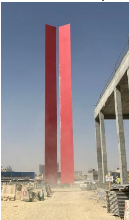
Figura 4. Torres del West Gate Entrance, en septiembre 2024 (Foto de RBTA)
