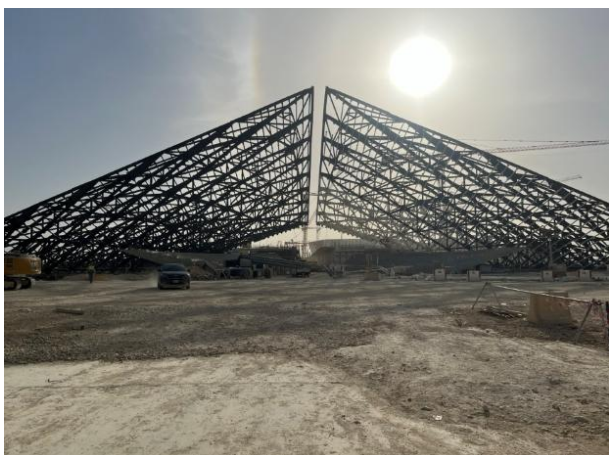
Figura 7. La cubierta piramidal del Outdoor Theatre (en obra en Sept. 2024).
