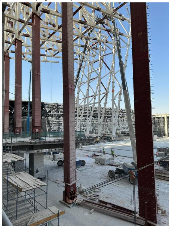
Figura 13. Soportes triangulares en la zona de la entrada (Porte Cochere)
