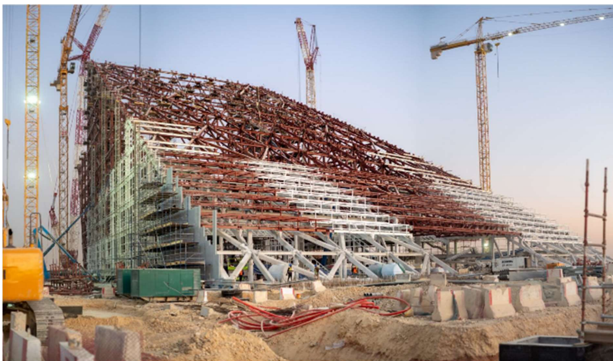
Figura 14. Estado de la construcción en enero de 2024
