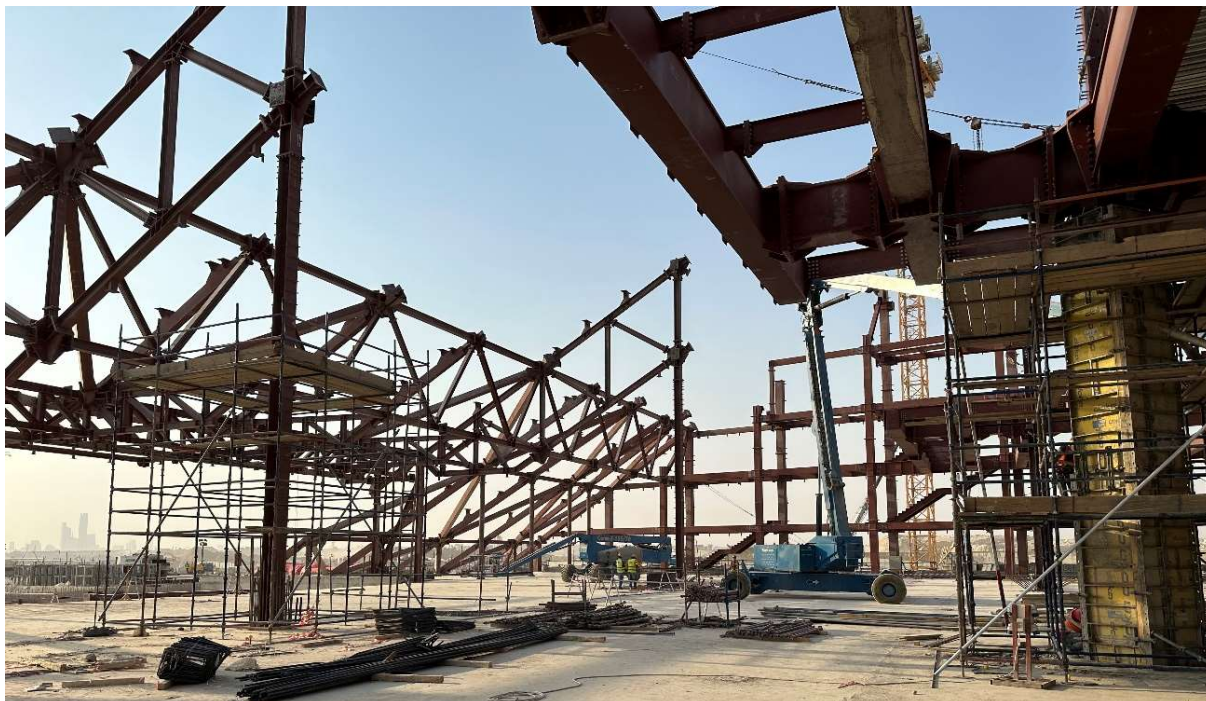
Figura 13. Estado de la construcción en septiembre de 2023
