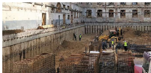
Figura 5. Vista de las pantallas de las fachadas Norte y Este tras realizar el vaciado interior de la parcela
