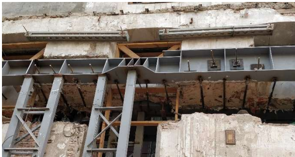
Figura 7. Vista del sistema de apeo provisional tras desvincular la fachada del muro de sótano.
