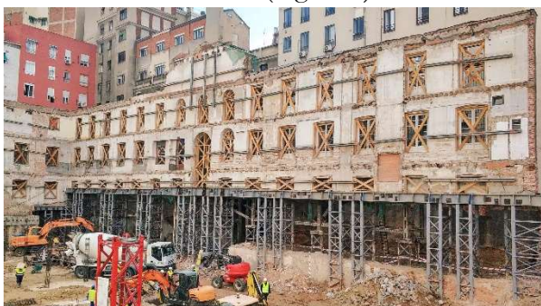
Figura 8. Vista general del interior de la fachada Sur del edificio de CSV28, tras la finalización de los trabajos de estabilización, apeo de fachada y demolición interior de la estructura original
