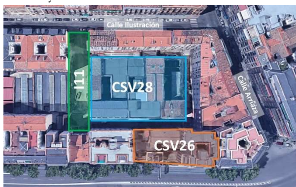
Figura 1. Vista aérea de los edificios que componen el complejo
