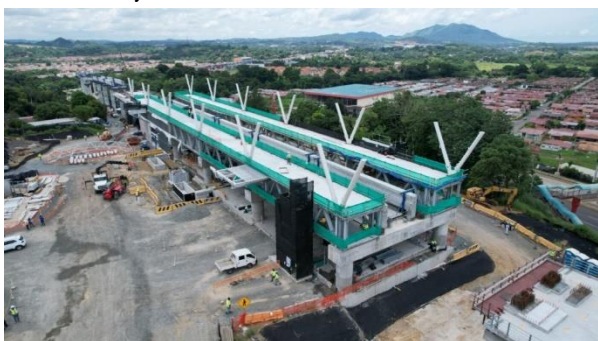
Figura 26. Imagen construcción estación pórtico
