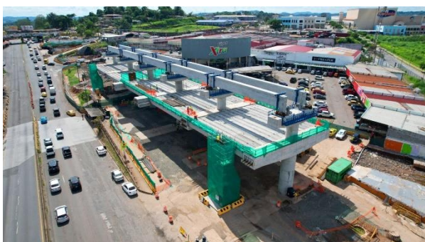
Figura 27. Imagen construcción estación monopila
