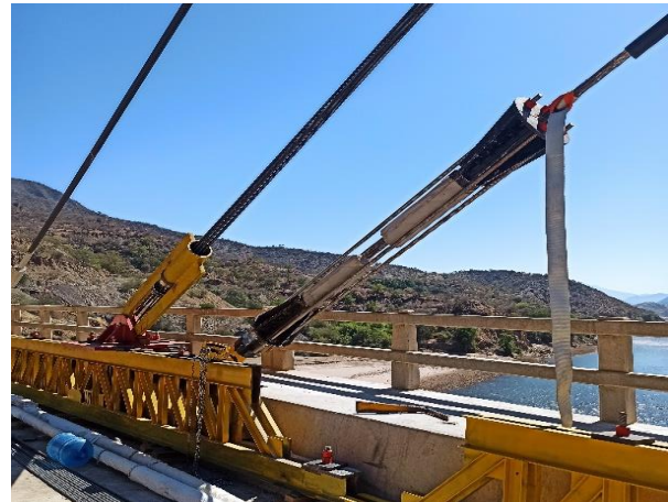
Figura 11. Brida de sujeción en tirante existente.
