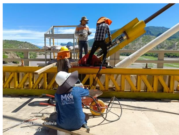
Figura 15. Destesado de tirantes provisionales
