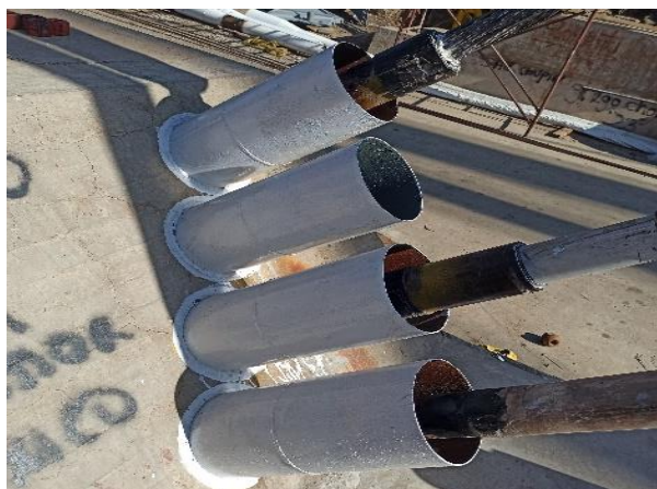
Figura 5. Tubos guía embebidos en estribos para tirantes de 12 torones.
