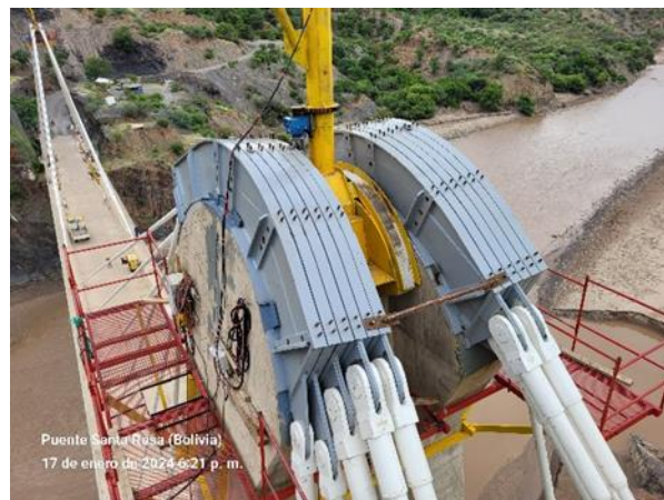
Figura 14. Conexión de tirantes nuevos a conector en cabeza de pila.
