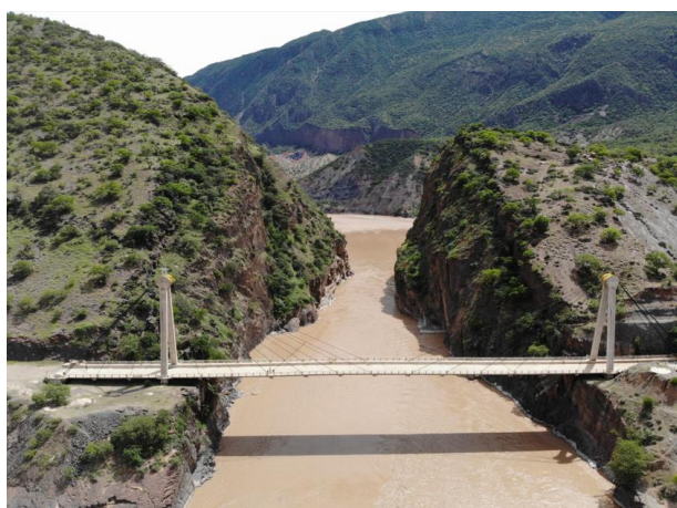
Figura 1. Vista general del puente Santa Rosa, antes de su intervención.
