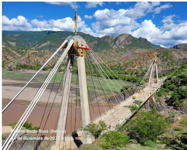
Figura 16. Vista general puente Santa Rosa al finalizar la sustitución de los tirantes.
