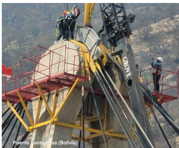
Figura 13. Instalación del primer conector de tirantes correspondiente al tirante 5 lado sur lado Santa Cruz.
