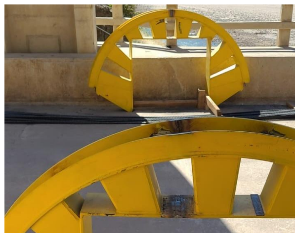
Figura 9. Desviador provisional sobre pila, antes de su instalación.
