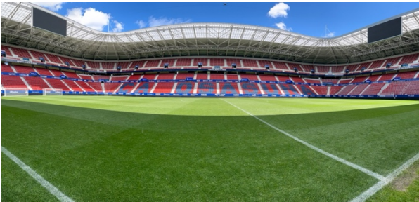
Figura 23. Vista panorámica de cubierta sobre graderíos
