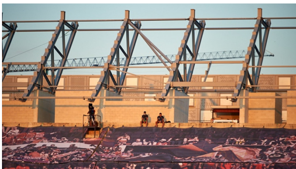
Figura 12. Ejecución de cerchas principales de graderío elevado, tramo central
