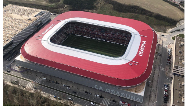
Figura 25. Foto aérea de El Sadar tras la finalización de las obras
