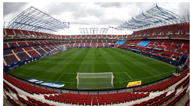
Figura 14. Ejecución de cerchas principales de cubierta, en grupos de tres
