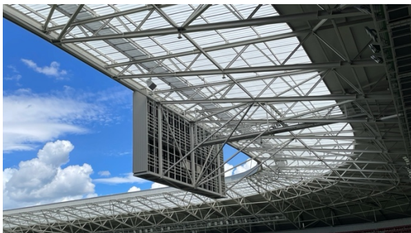
Figura 21. Detalle de cubierta y estructura de video marcador
