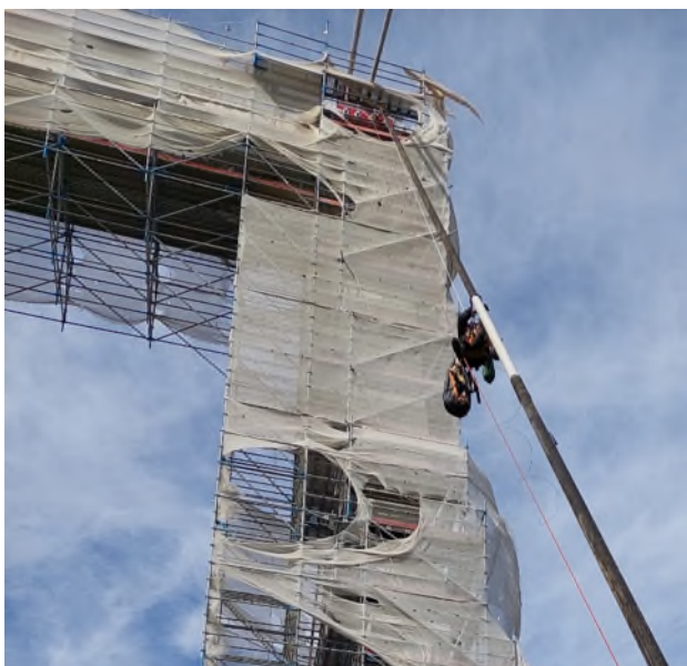
Figura 5. Remoción del enrolamiento de confinamiento de los tirantes originales.
