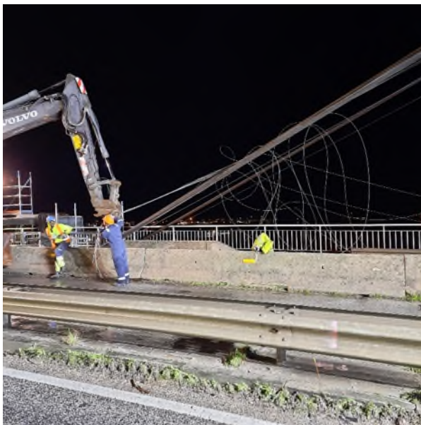
Figura 7. Remoción de alambres cortados.
