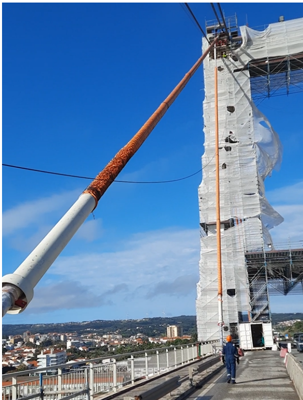
Figura 6. Instalación de los cordones provisionales.
