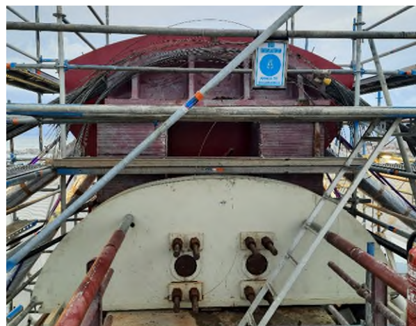
Figura 3. Sillas de los tirantes provisionales.
