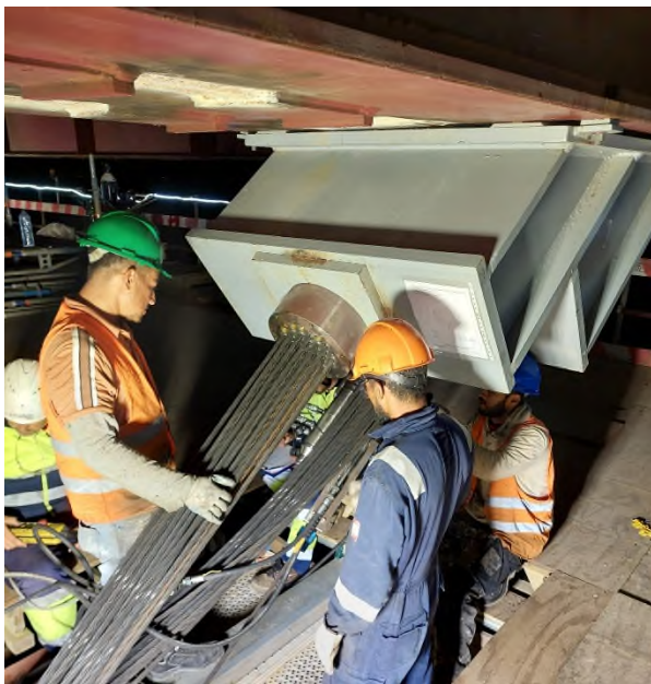
Figura 4. Anclajes de los tirantes provisionales en el tablero.
