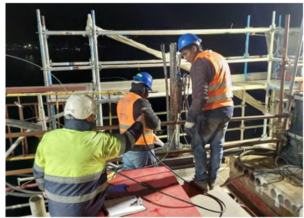
Figura 8. Tesado de tirante de retenida.
