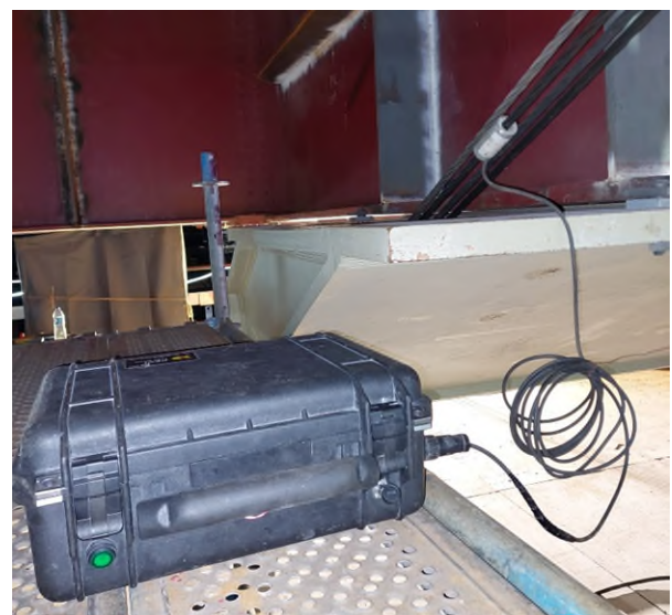
Figura 13. Medición de fuerza en los tirantes provisionales.
