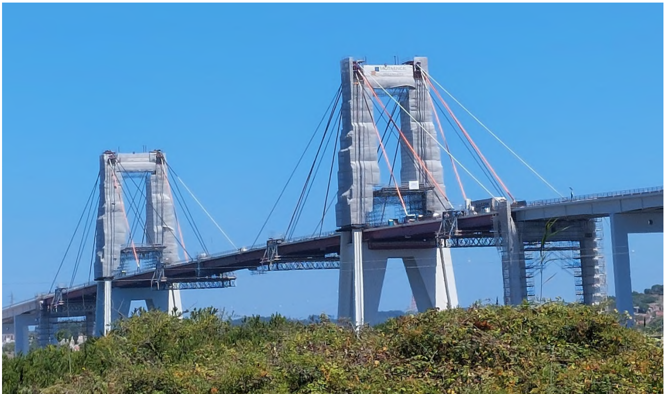
Figura 1. Vista general del puente atirantado [1]
