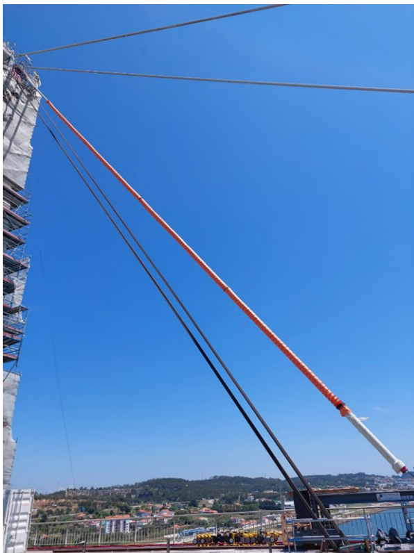
Figura 12. Tirante definitivo con la manguera de protección.
