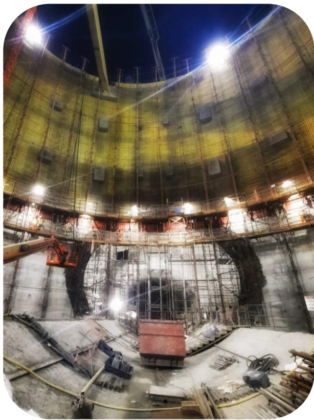
Figura 11. Fotografía del proceso de ejecución del deslizado.
