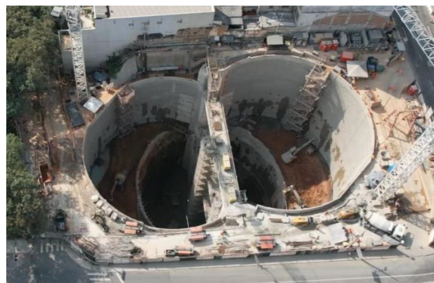
Figura 19. Vista aérea de la Estación de São Joaquim en fase de ejecución del pozo de alargamiento y demolición del pozo de ataque.
