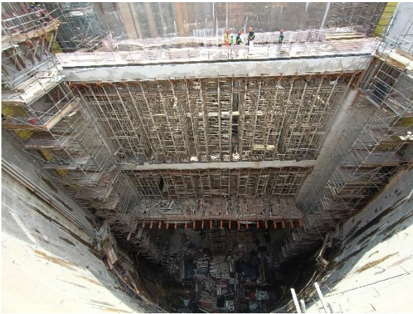
Figura 8. Ejecución de los pilares del pórtico.
