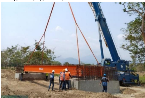
Figura 11. Elevación de las vigas de acero
