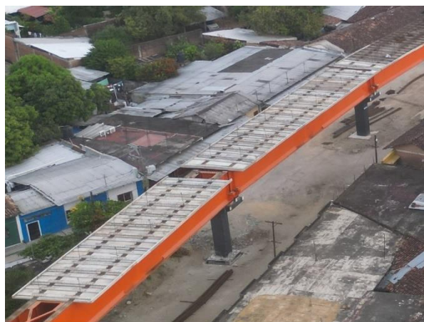
Figura 13. Prelosas de hormigón de vanos mixtos bijácenos.
