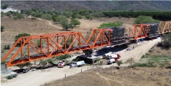
Figura 17. Rehabilitación de cerchas
