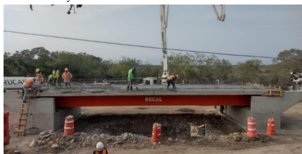
Figura 14. Vertido de la losa superior
