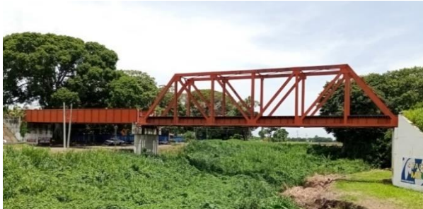
Figura 15. Vista general de cerchas soldadas y vanos tipo U a mantener
