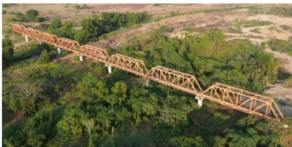
Figura 16. Puente para rehabilitación total
