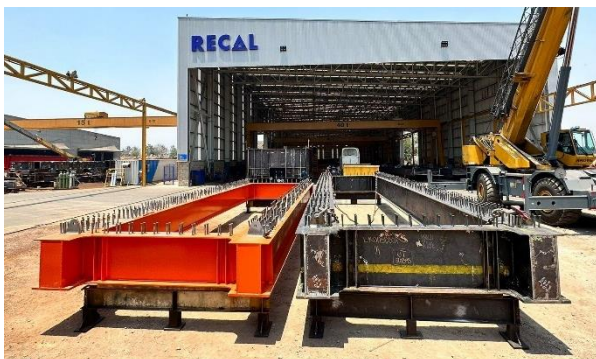
Figura 4. Sección transversal del tablero de vigas cajón gemelas
