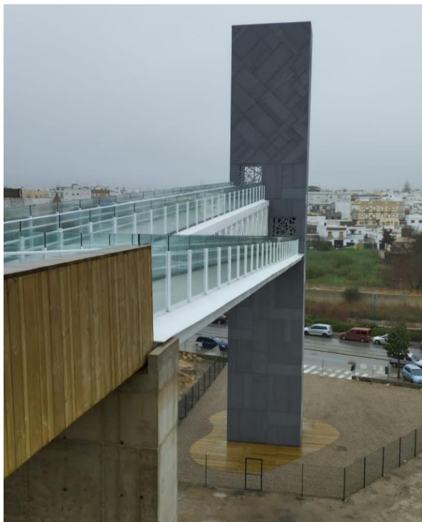
Figura 15. Vista de estructura desde lado del Cerro.
