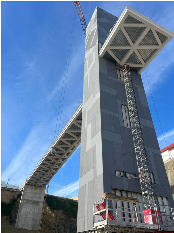
Figura 9. Fotografía de estructura en construcción, donde se observan las celosías de arriostramiento horizontal.
