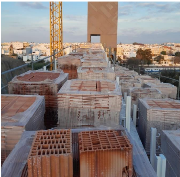
Figura 14. Prueba de carga.
