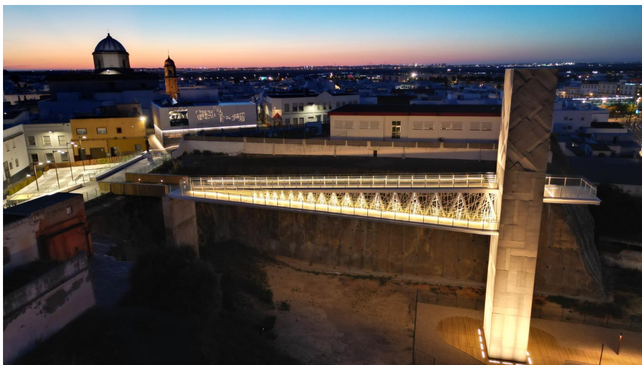
Figura 2. Vista longitudinal de la estructura completa.
