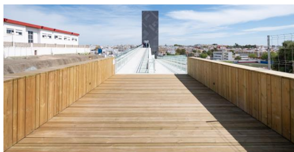
Figura 3. Vista desde la pasarela desmontable.
