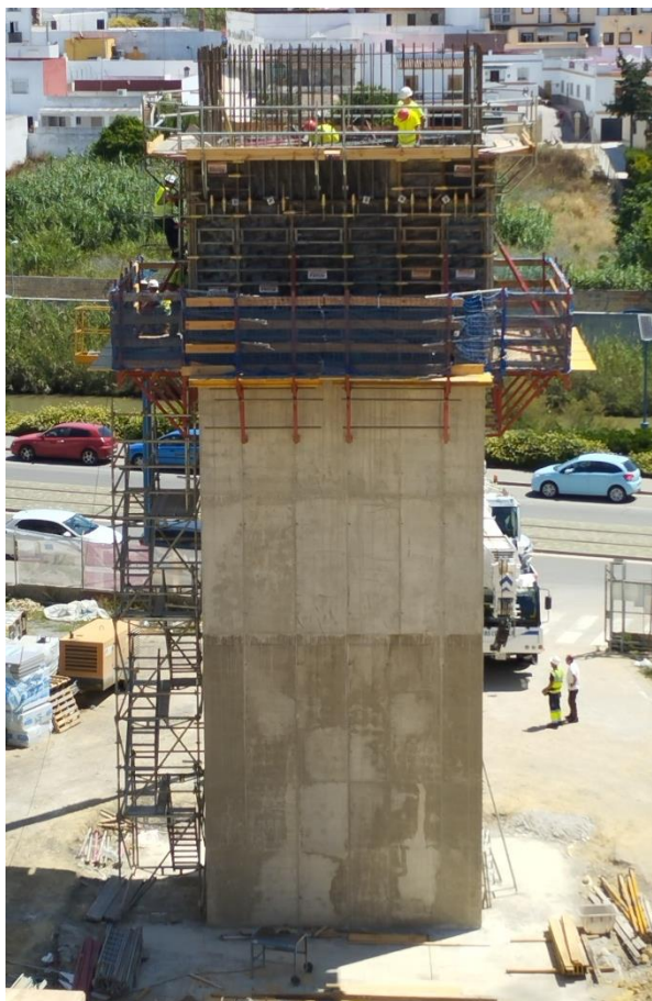
Figura 13. Imagen de construcción de la torre.
