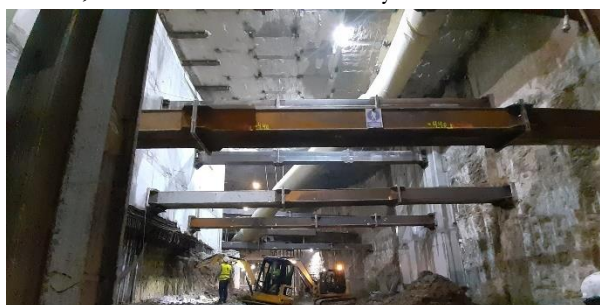
Figura 14 Apuntalamiento de los muros.
