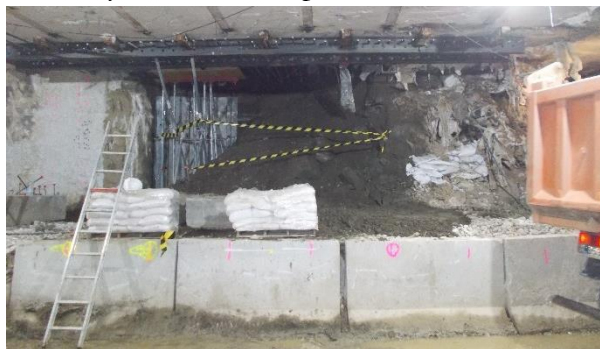
Figura 12 Estado de excavación inicial.
