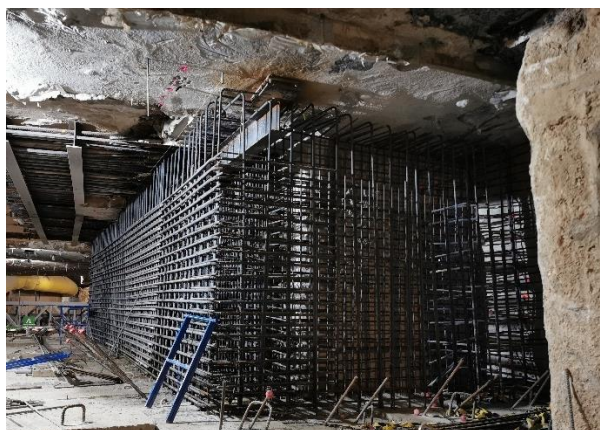
Figura 13 Ferrallado de muro de margen derecha.
