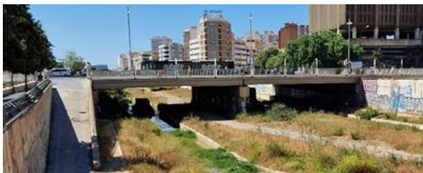
Figura 3 Antiguo Puente Tetuán bajo el que cruza la línea de Metro.
