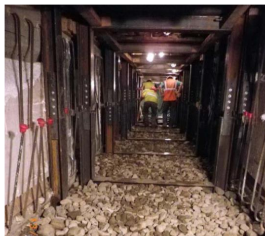
Figura 11 Ilustración de excavación para viga.
