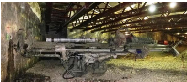
Figura 6 Ejecución de los micropilotes bajo cerchas de apuntalamiento entre pantallas.
