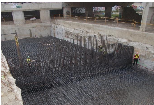
Figura 21 Ferrallado de losa de cubierta, esperas de pilas y refuerzos locales en conexión a pantallas.
