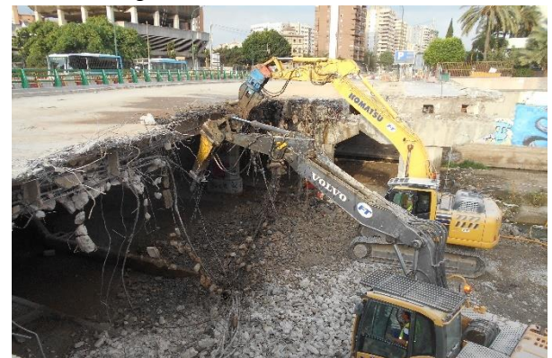
Figura 19 Trabajos de demolición del tablero.
