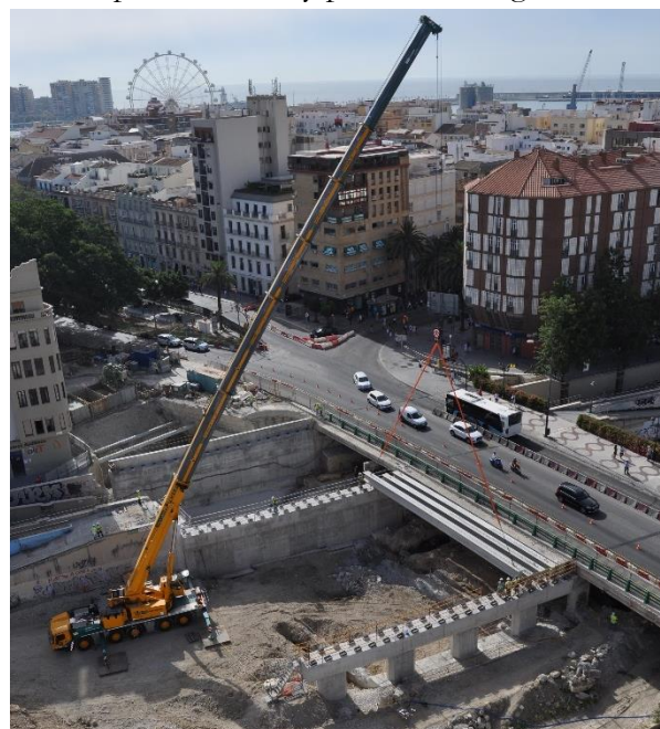
Figura 22 Colocación de vigas del tablero.
