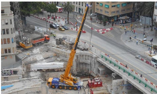
Figura 20 Vista aérea de comienzo de trabajos para túnel de Metro tras demolición de puente.
