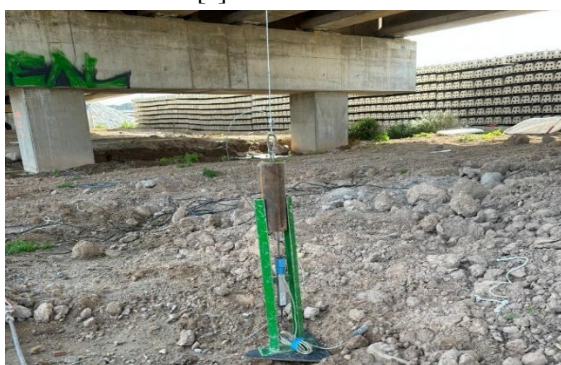
Figura 3. Instalación del transductor potenciométrico de desplazamiento en el puente de estudio.
