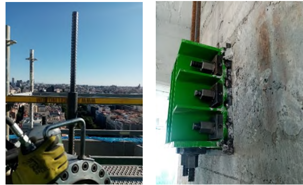
Figura 2. Detalles anclaje vertical superior e inferior
