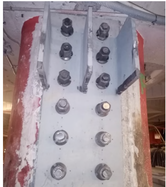
Figura 5. Vista barras tesadas
