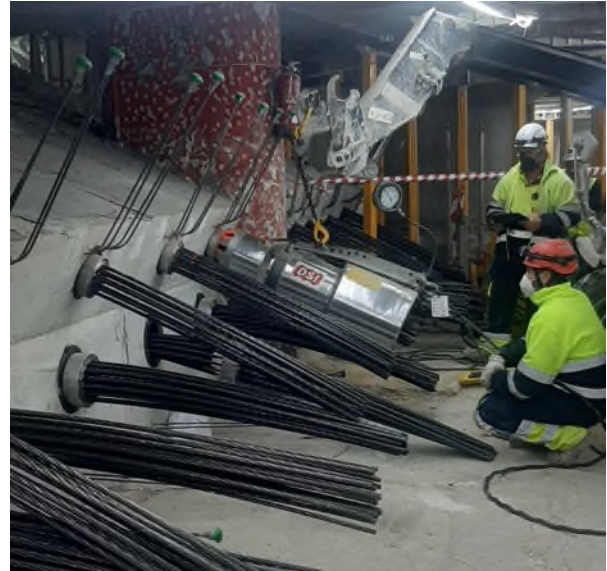
Figura 7. Tesado anclajes cimentación
