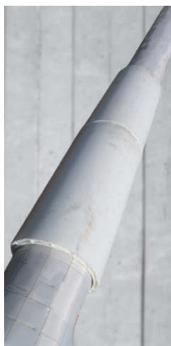
Figura 13. Detalle protección ignífuga tirantes con mantas enrolladas
