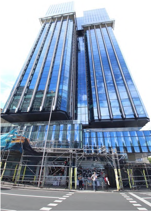
Figura 17. Vista general una de las fachadas en obra con los tirantes instalados
