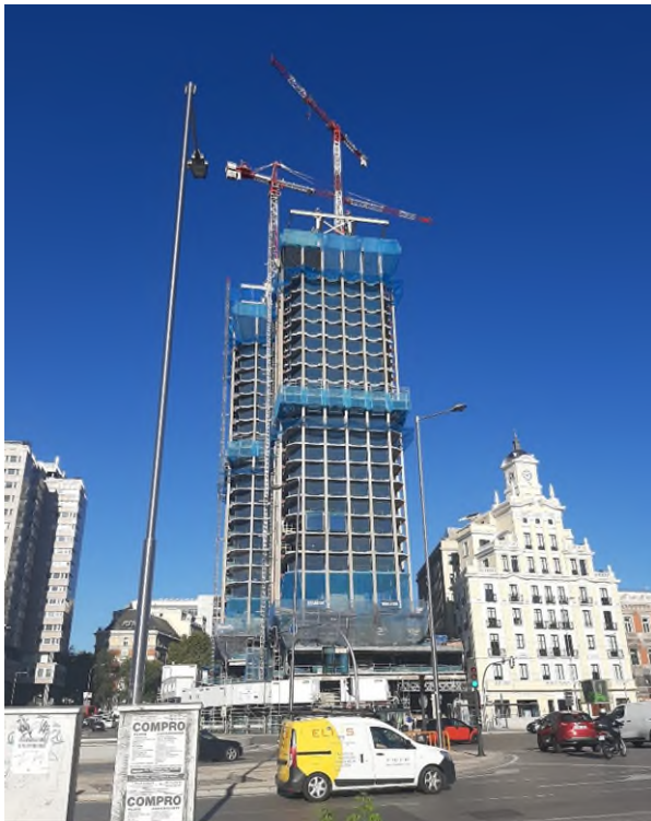
Figura 1. Vista general del edificio con las dos grúas torre instaladas.
