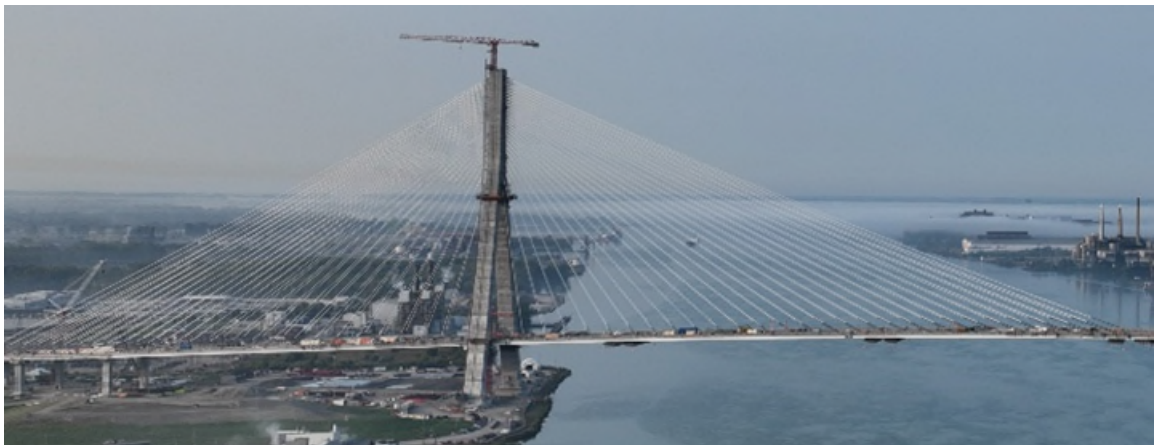
Figura 3. Disposición longitudinal de tirantes
