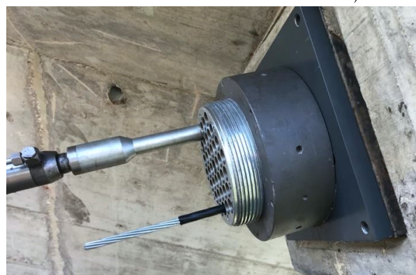
Figura 5. Cordón enfundado atravesando el anclaje
