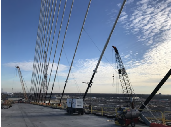
Figura 12. Cables transversales temporales
