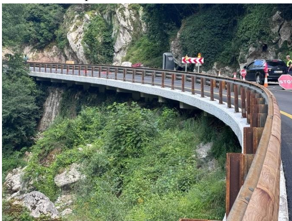
Figura 7. Estructura terminada con voladizo progresivo.
