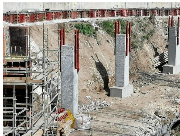
Figura 20. Pilas en estructura de apoyos aislados.
