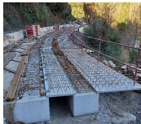
Figura 6. Prelosas y zunchos en voladizo < 1.5 m.
