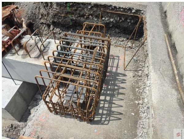
Figura 19. Encepado trasero ferrallado.
