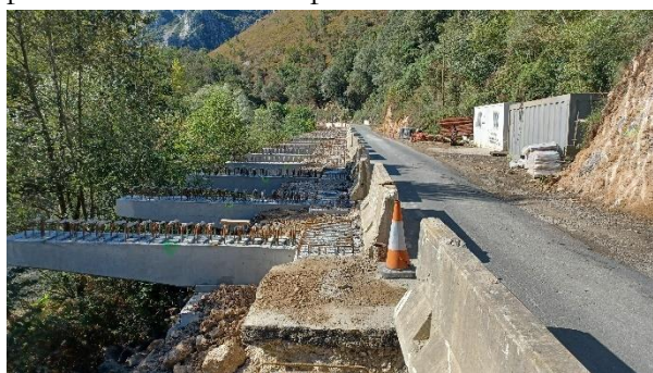
Figura 16. Costillas tipo A instaladas.
