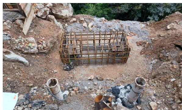
Figura 18. Encepado delantero ferrallado.
