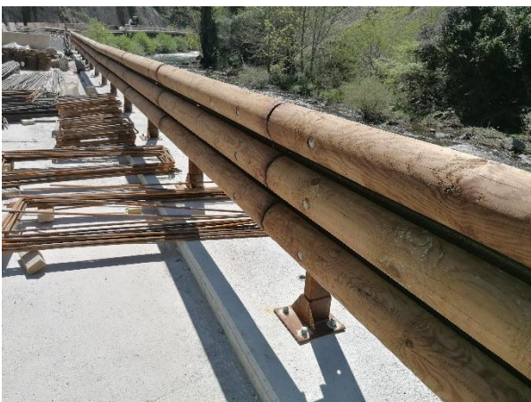
Figura 3. Barrera de protección instalada.
