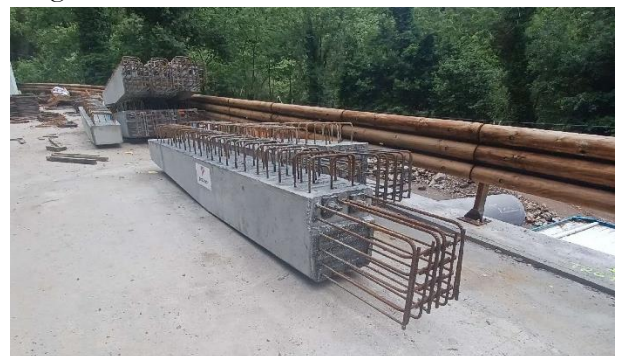
Figura 8. Costilla prefabricada.
