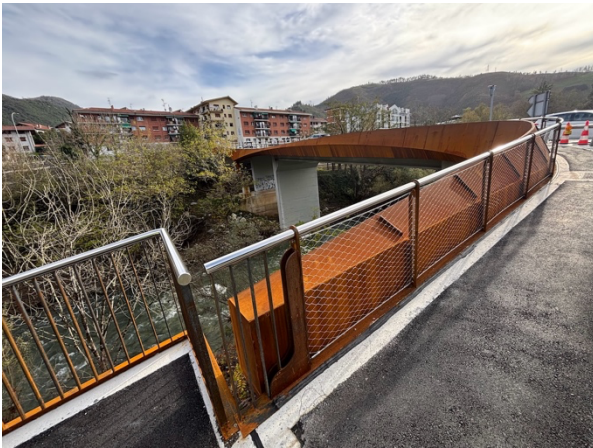
Figura 1. Viga aguas abajo
