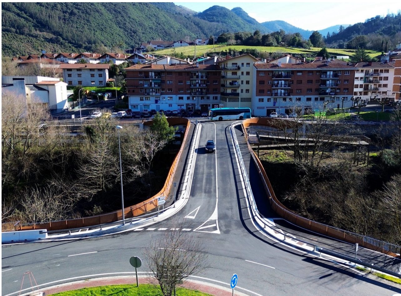
Figura 17. Puente de Mendaro rehabilitado.
