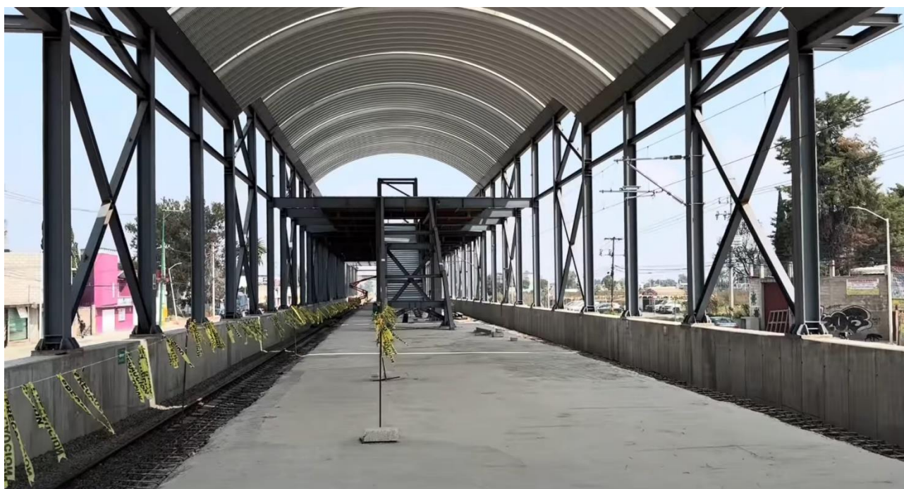
Figura 16. Vista del tramo lateral de la estación de Nextlalpan. Estado de la construcción en diciembre de 2024.
