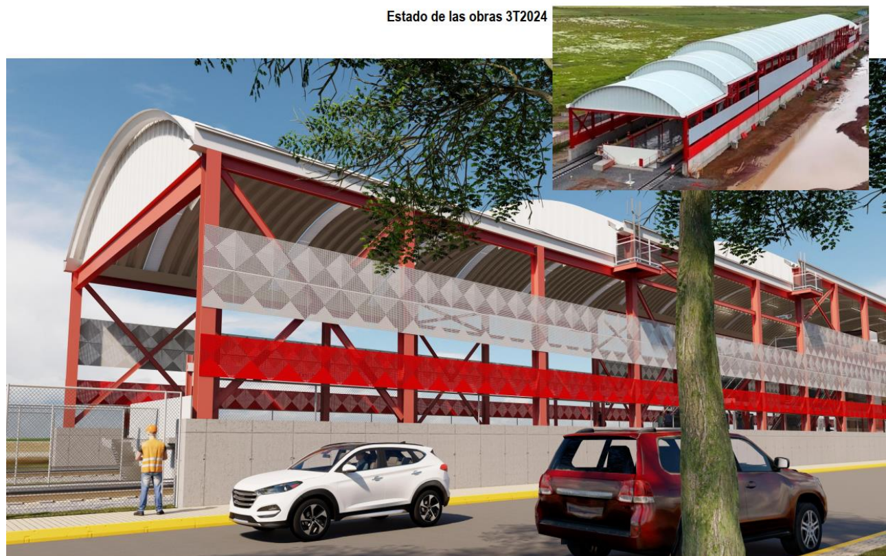
Figura 1. Vista general de una infografía de la Estación 6 Jaltocán. En la esquina superior derecha se muestra el avance de las obras en el tercer trimestre de 2024.
