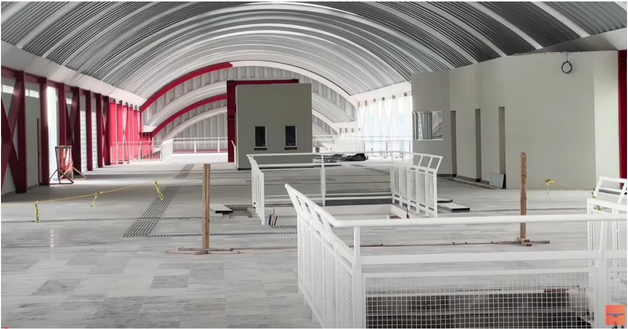
Figura 18. Vista del vestíbulo de la Estación 6 Jaltocán. Se aprecian los huecos de escaleras y las estancias.
