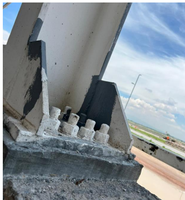
Figura 15. Unión ejecutada en obra.
