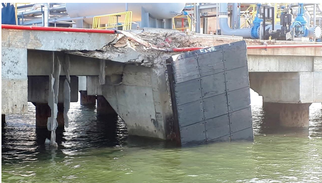
Figura 4. Estado de la plataforma tras el impacto del Sino Star.
