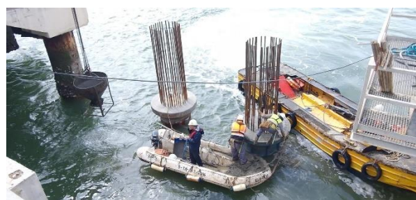
Figura 16. Copas de apoyo sobre los pilotes.
