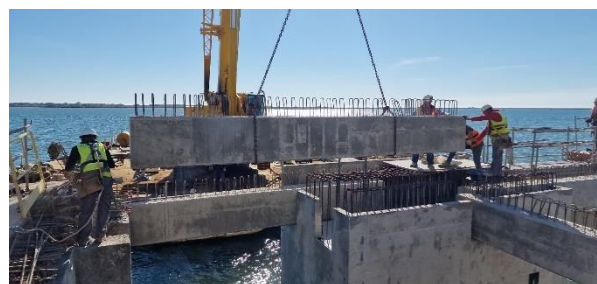
Figura 20. Colocación de vigas prefabricadas.
