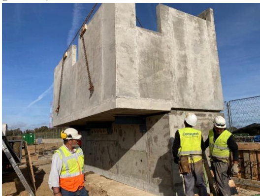
Figura 17. Prueba del cabecero prefabricado.
