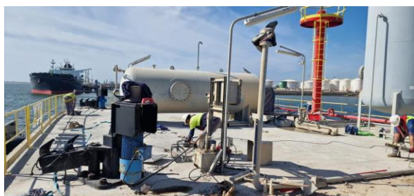
Figura 24. Restitución de equipos mecánicos.
