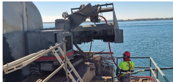
Figura 12. Hidrodemolición de la plataforma
