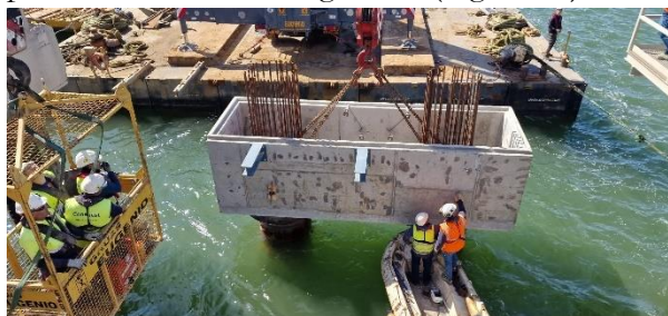
Figura 18. Colocación cabecero inferior prefabricado.
