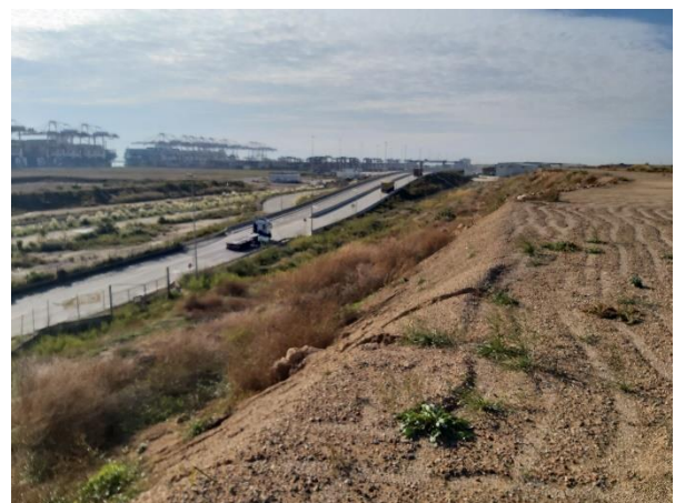
Figura 22. Vista de la Ronda del Port desde la coronación de la zona con precarga.
