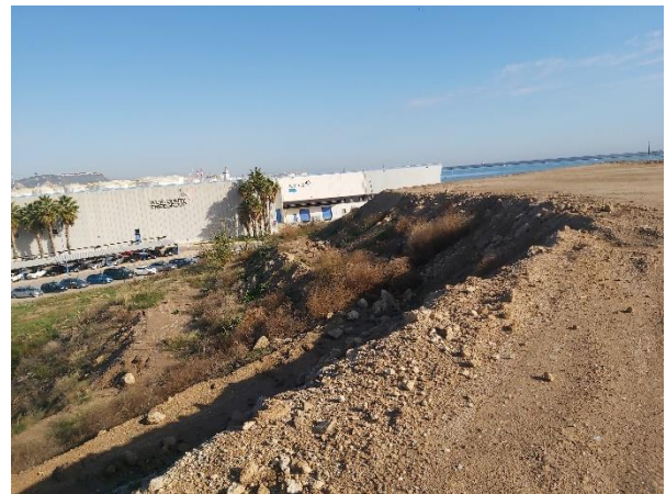
Figura 21. Vista de la Av. Ports d'Europa desde la coronación de la zona con precarga.
