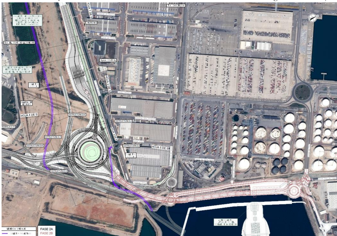
Figura 1. Vista general de la actuación. Fase 2A (glorieta) a la izquierda y Fase 2B (viaducto) hacia la derecha.
