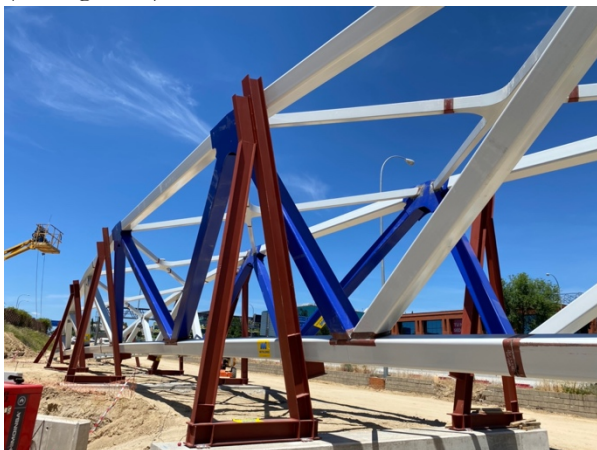
Figura 8. Castilletes de montaje en obra
