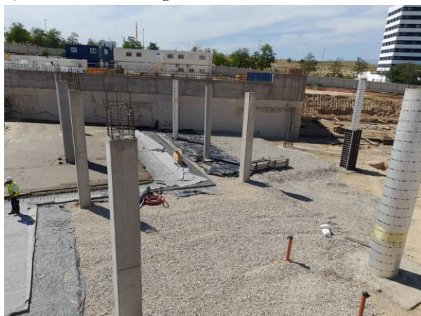
Figura 8. Pilares de intercambiador.
