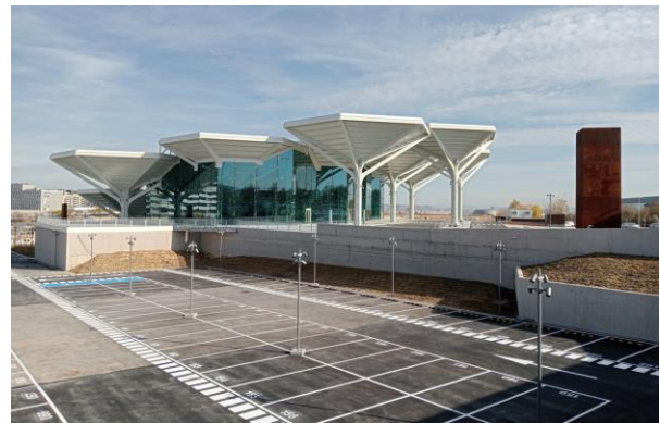
Figura 6. Vista de aparcamiento disuasorio.
