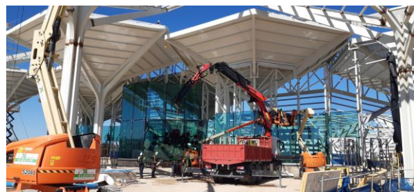
Figura 28. Montaje de cerramiento de vidrio sobre cerchas metálicas.
