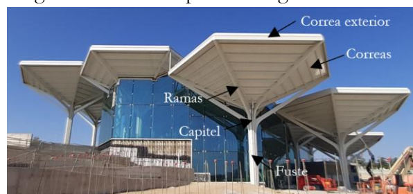
Figura 17. Partes de la estructura de cubierta.
