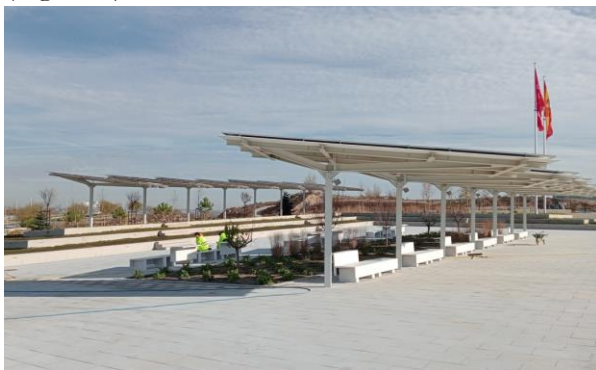
Figura 5. Marquesinas soporte de planta fotovoltaica en zona exterior de recreo.
