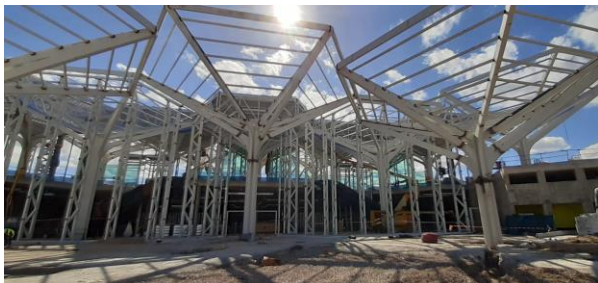
Figura 18. Vista general de estructura metálica durante la ejecución de las obras.
