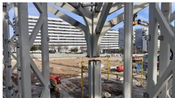
Figura 25. Detalle de montaje de árboles sobre fuste.
