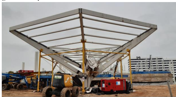
Figura 22. Vista general de bancada y premontaje de parte superior de árboles.
