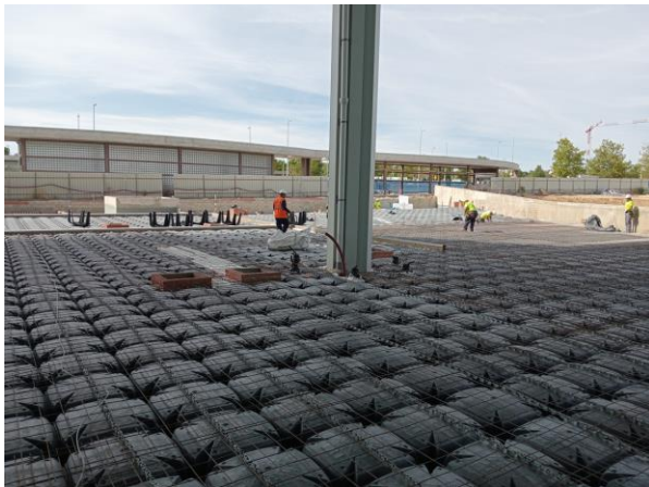
Figura 12. Ejecución de solera elevada sobre el forjado reticular.
