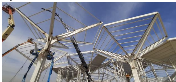
Figura 26. Trabajos de montaje de árboles.
