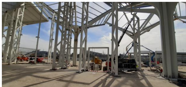
Figura 27. Vista de celosías soporte de muro cortina.
