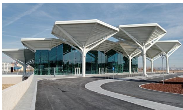
Figura 31. Vista general del Intercambiador de Valdebebas.
