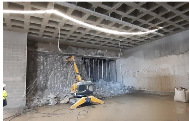
Figura 13. Apertura de hueco para conexión con la estación de Cercanías.
