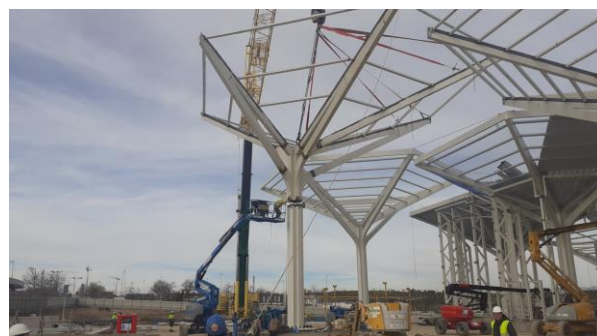
Figura 24. Montaje de parte superior de árbol sobre su fuste.
