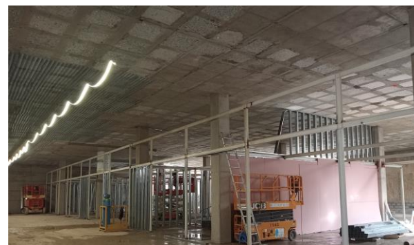
Figura 11. Vista inferior de forjado reticular.
