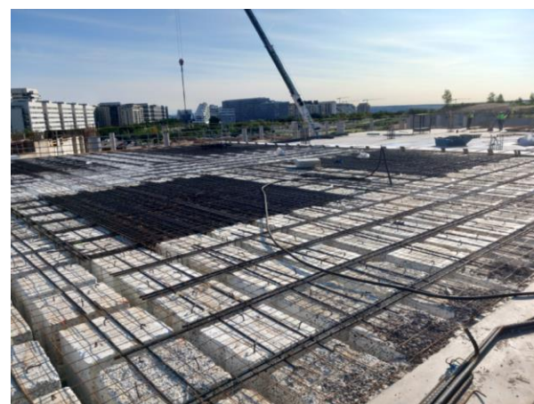
Figura 10. Vista superior de ejecución de forjado reticular con casetones perdidos y zonas de ábacos macizos.
