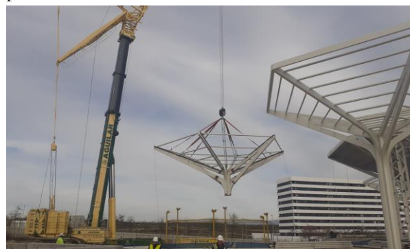
Figura 23. Izado de parte superior de árbol premontado.
