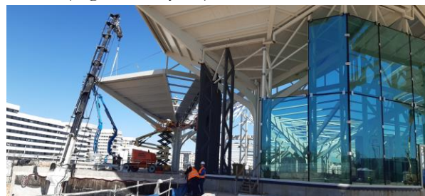
Figura 29. Trabajos de estructura metálica, cubierta y cerramiento perimetral de vidrio.
