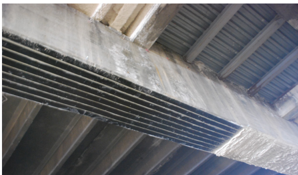
Figura 23. Refuerzo a flexión de pórtico ejecutado en obra
