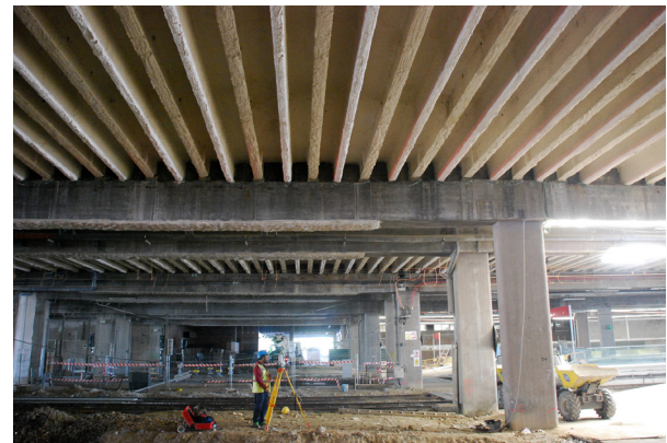
Figura 21. Refuerzo de vigas pi finalizado y protegido contra el fuego
