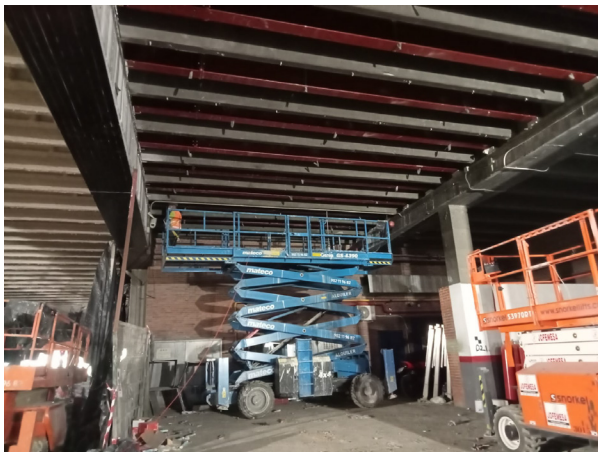
Figura 14. Vigas metálicas completamente instaladas
