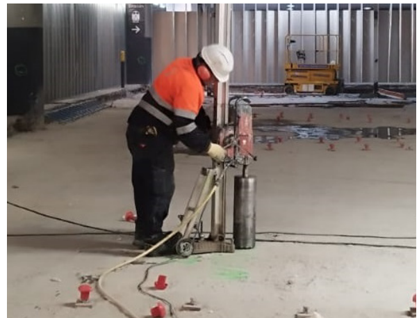
Figura 16. Ejecución de taladros en estructura existente y colocación de pernos conectadores
