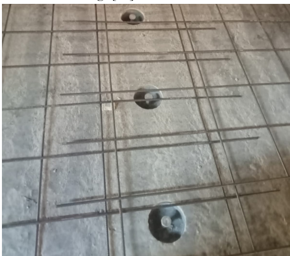
Figura 20. Ferrallado de la nueva capa de compresión.
