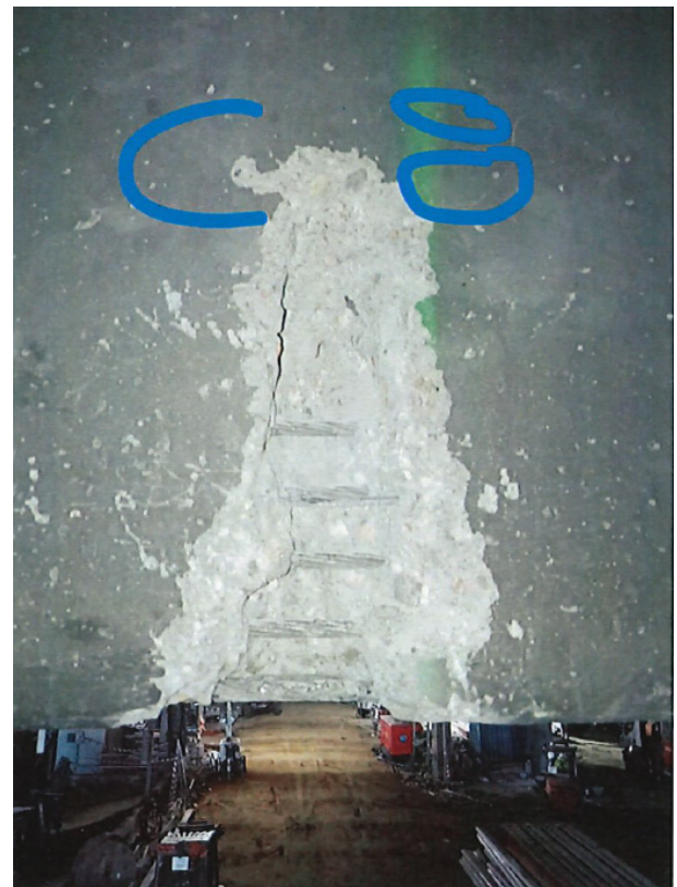
Figura 4. Cata para determinar la armadura real de las vigas pi
