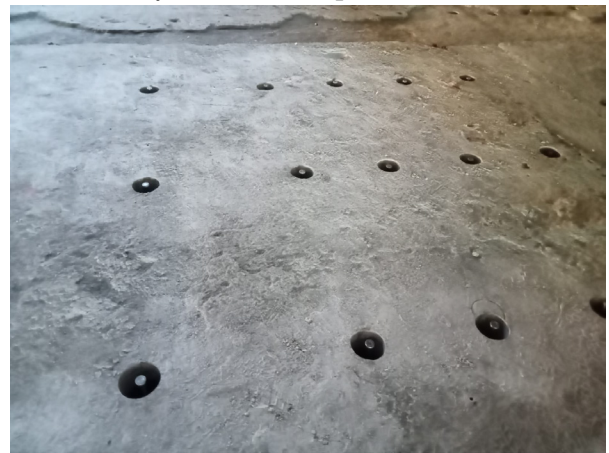
Figura 17. Instalación de pernos conectadores
