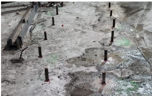
Figura 25. Barras de refuerzo vertical para ménsulas laterales
