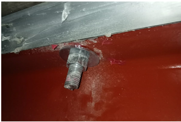
Figura 19. Conexión inferior con varillas postinstaladas
