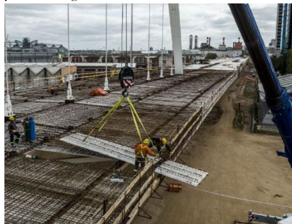
Figura 24. Instalación de última prelosa en el tramo del arco
