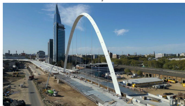
Figura 25. Losa totalmente hormigonada
