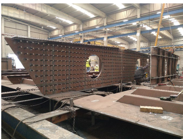
Figura 15. Montaje de diafragmas de pilas en taller
