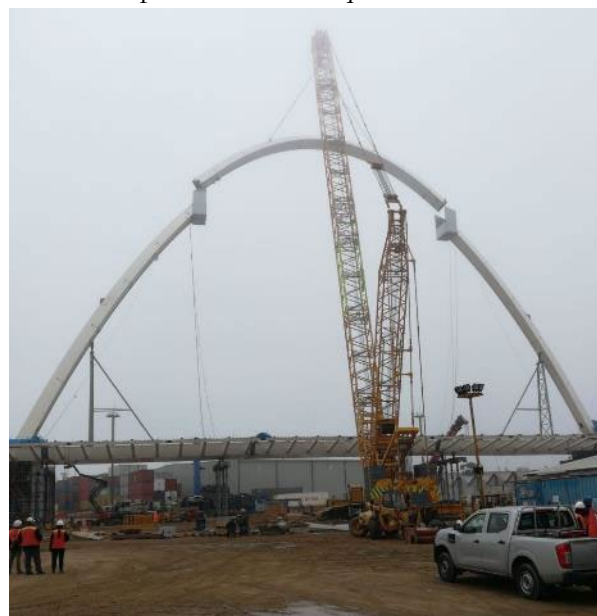
Figura 21. Montaje de la clave del arco
