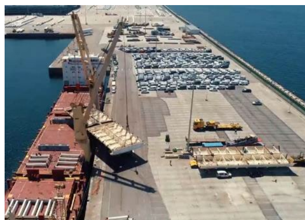
Figura 16. Carga del tablero al buque en el puerto de Vigo
