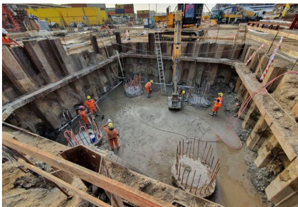
Figura 7. Recinto tablestacado para encepado
