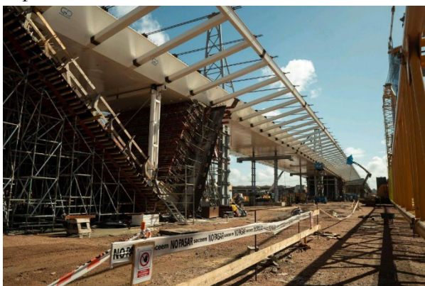
Figura 19. Montaje del tablero completado
