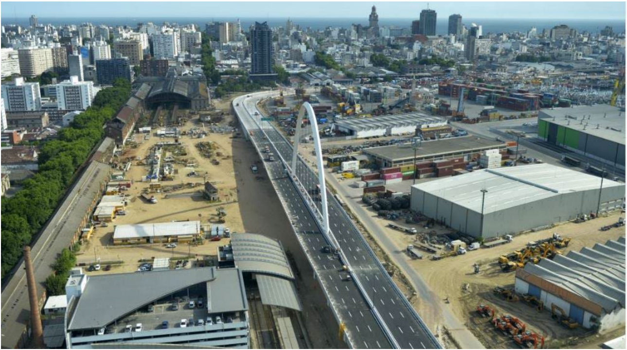
Figura 26. Vista general aérea de la obra terminada
