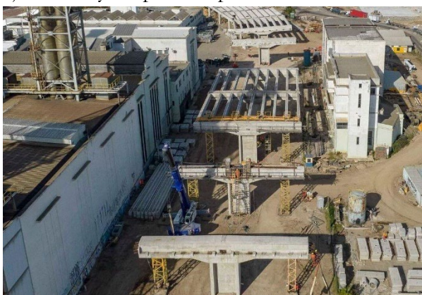
Figura 11. Colocación de vigas prefabricadas
