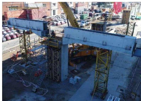
Figura 8. Montaje de tramos prefabricados de dintel
