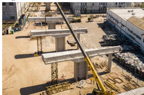
Figura 9. Dinteles en tramos curvos
