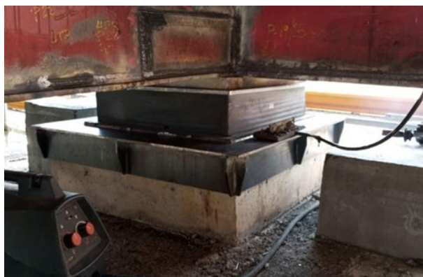
Figura 21. Cambio de apoyos en pilas
