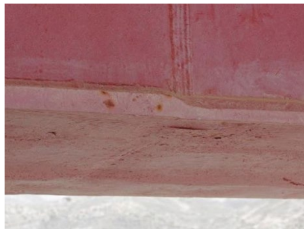
Figura 7. Transiciones bruscas de espesores
