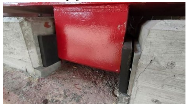
Figura 20. Vista de tope de estribo ejecutado
