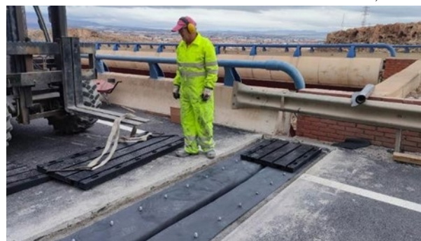
Figura 22. Instalación de nueva junta de dilatación
