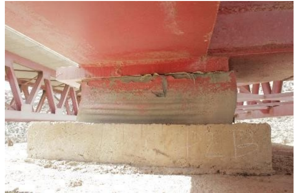
Figura 11. Apoyo desplazado
