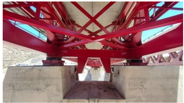
Figura 19. Vista de tope de pila ejecutado
