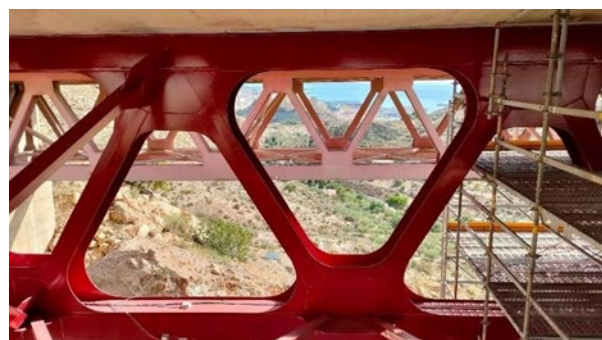
Figura 16. Vista general de nudos reforzados
