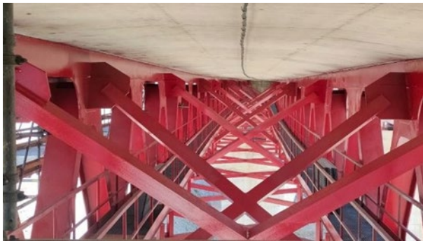
Figura 18. Arriostramiento superior retirado
