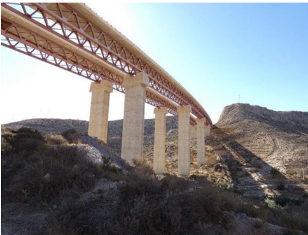
Figura 1. Vista general del viaducto
