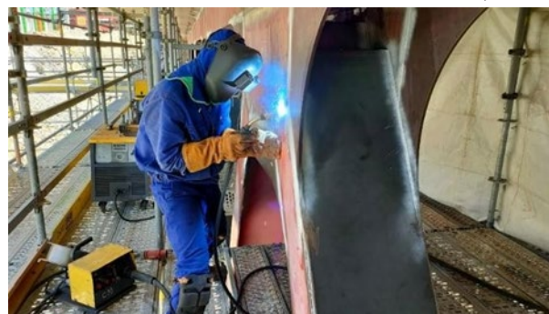
Figura 17. Refuerzo de diagonal
