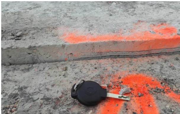
Figura 11. Corte longitudinal entre vigas, en la que se observa la flecha relativa.
