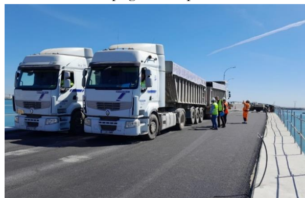
Figura 20. Prueba de carga
