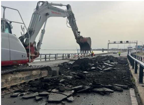
Figura 8. Demolición y retirada del pavimento
