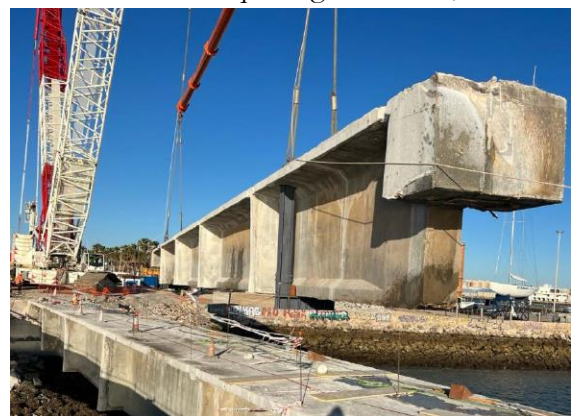
Figura 13. Izado de una de las vigas completas
