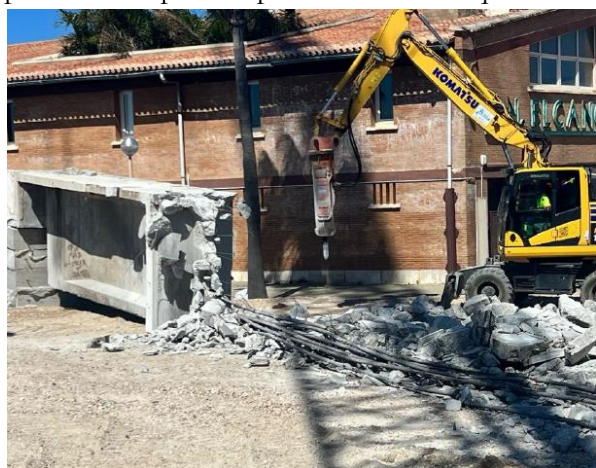
Figura 15. Demolición de una de las vigas
