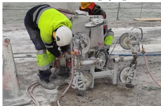
Figura 10. Corte transversal de una riostra intermedia
