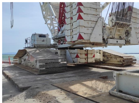
Figura 7. Plataforma y elementos de reparto de la carga.
