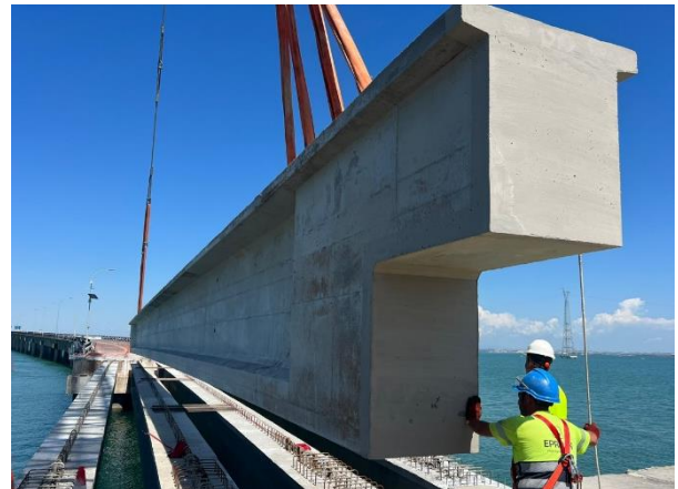
Figura 17. Montaje de vigas
