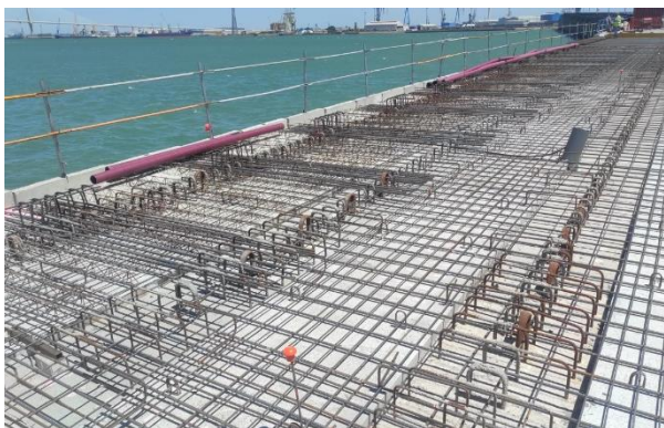
Figura 19. Armado de la losa de compresión
